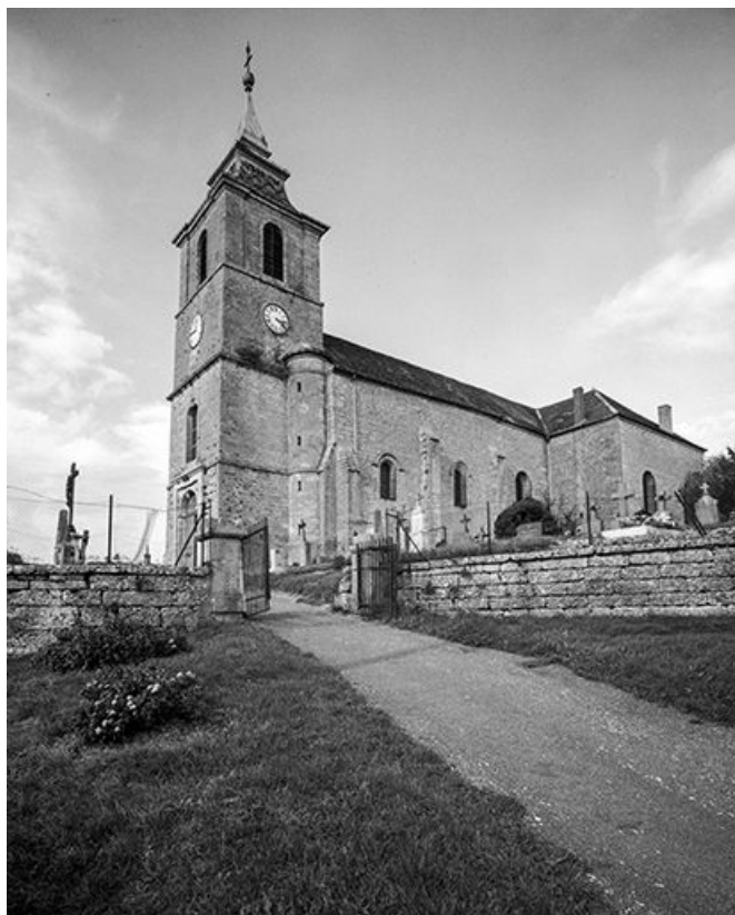
Tour-clocher et façade latérale droite.
