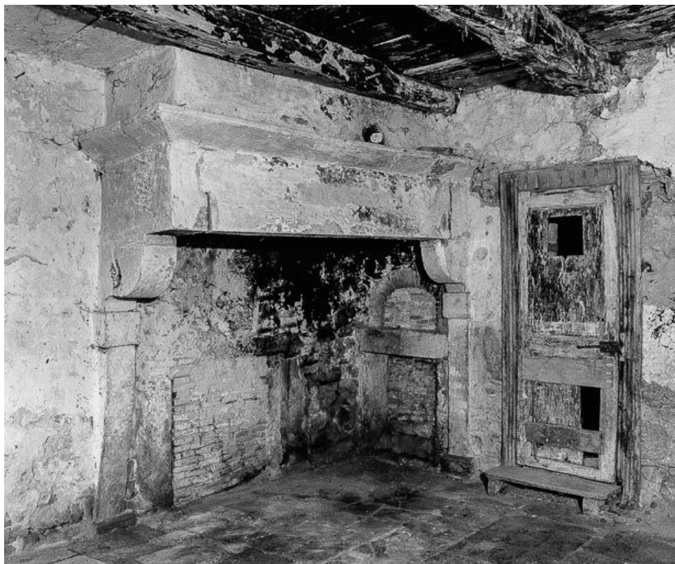
Intérieur : cheminée de la cuisine.
