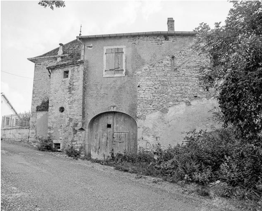
Vue rapprochée de la façade latérale droite.
