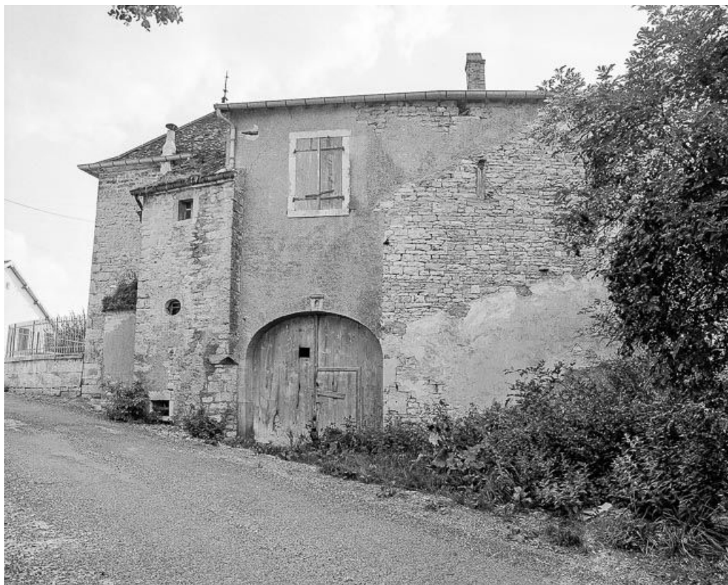
Vue rapprochée de la façade latérale droite.
