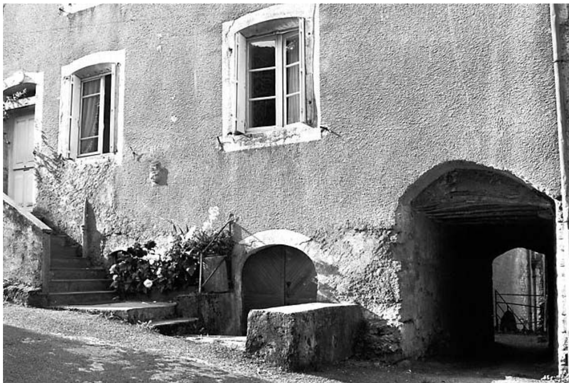
Vue du rez-de-chaussée.
