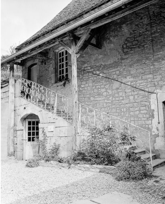
Détail de l'escalier extérieur de l'habitation.
