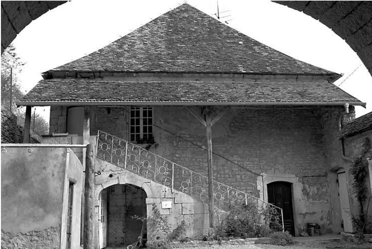
Façade sur cour de l'habitation.
