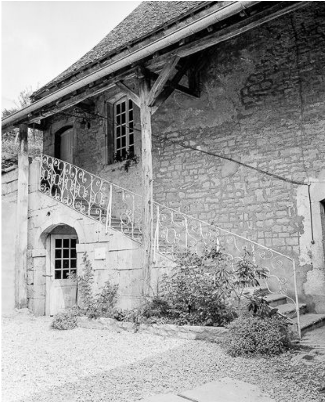
Détail de l'escalier extérieur de l'habitation.
