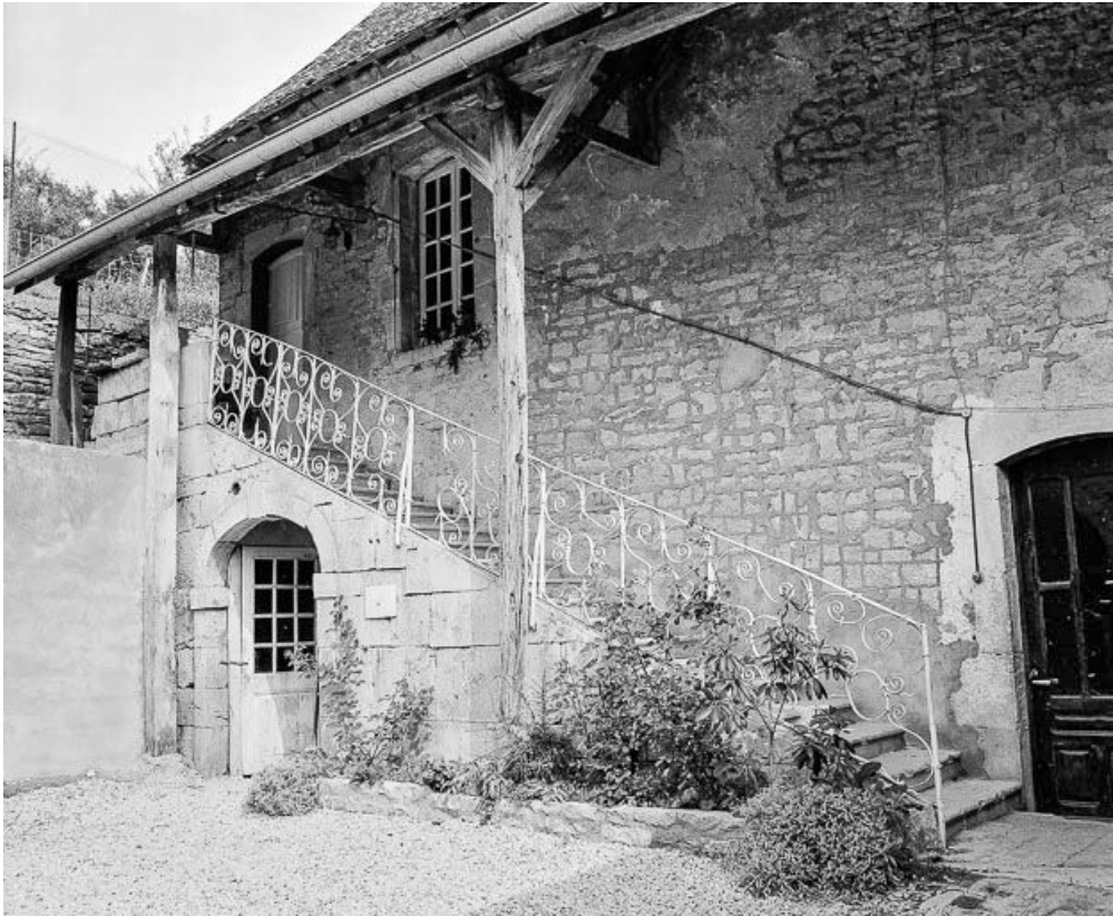
Détail de l'escalier extérieur de l'habitation.
