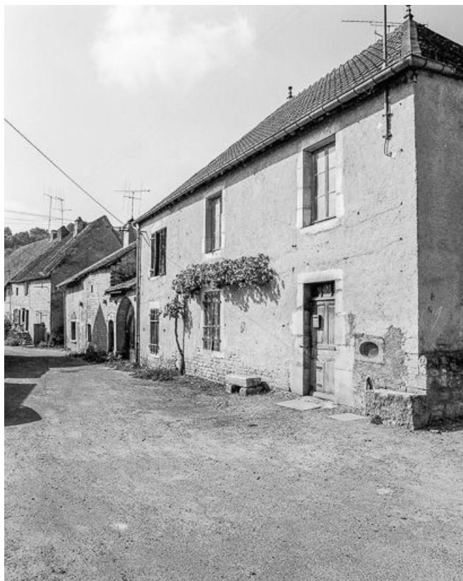
Façade antérieure de l'habitation.
