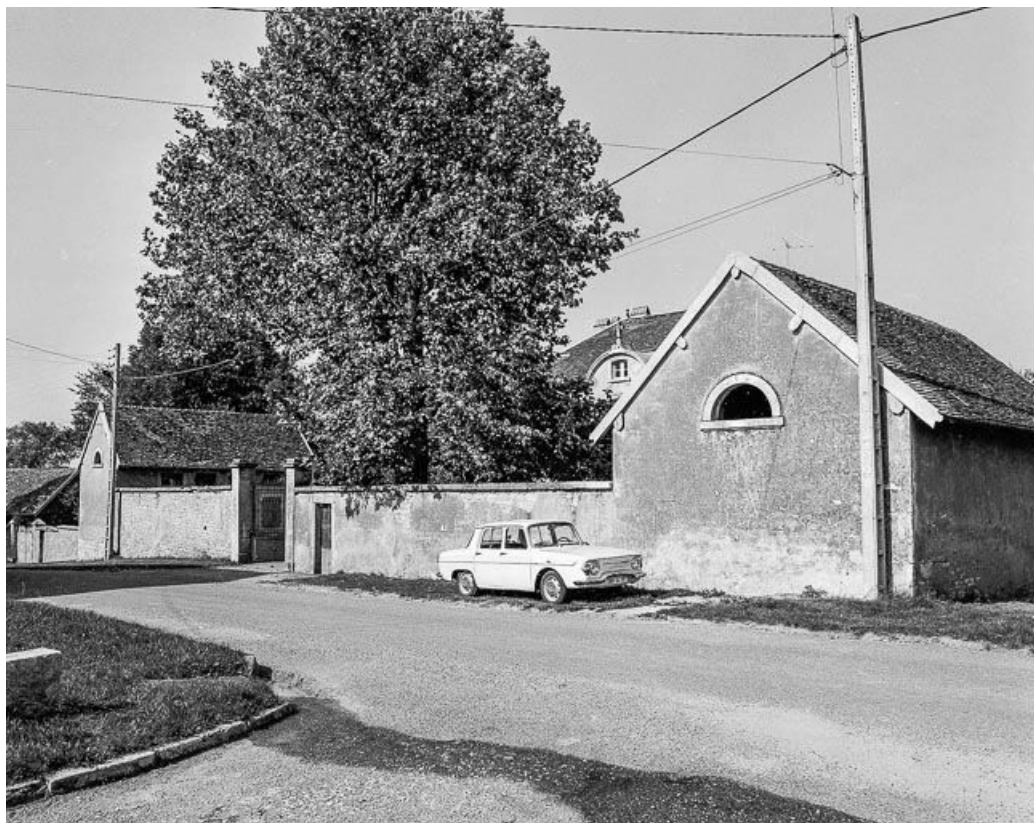
Vue générale depuis la rue. 70, Bucey-lès-Gy rue du Mont
