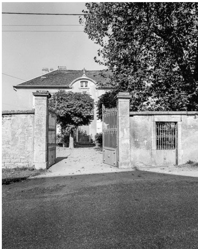
L'habitation depuis le portail d'entrée.
