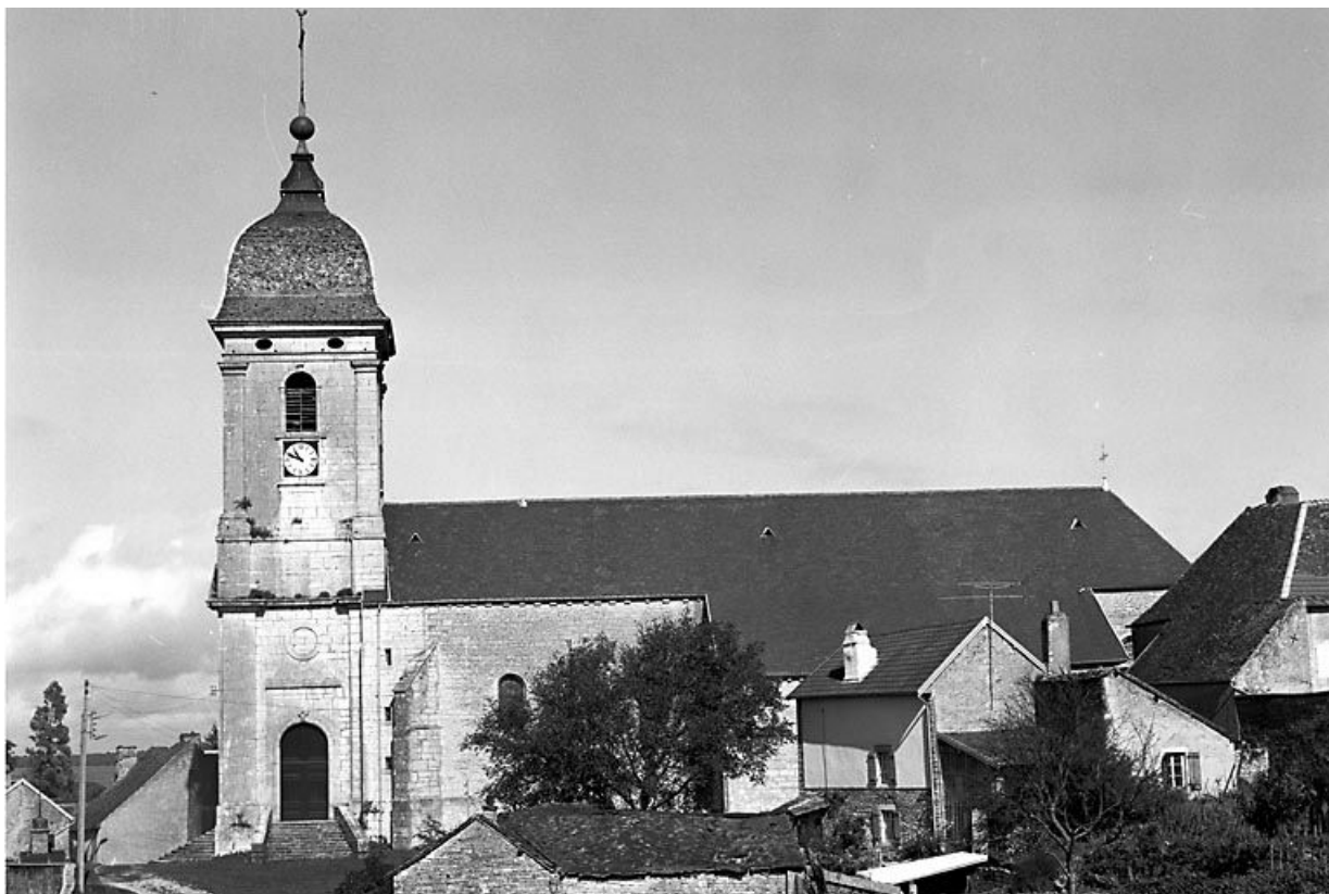
Façade latérale droite.
