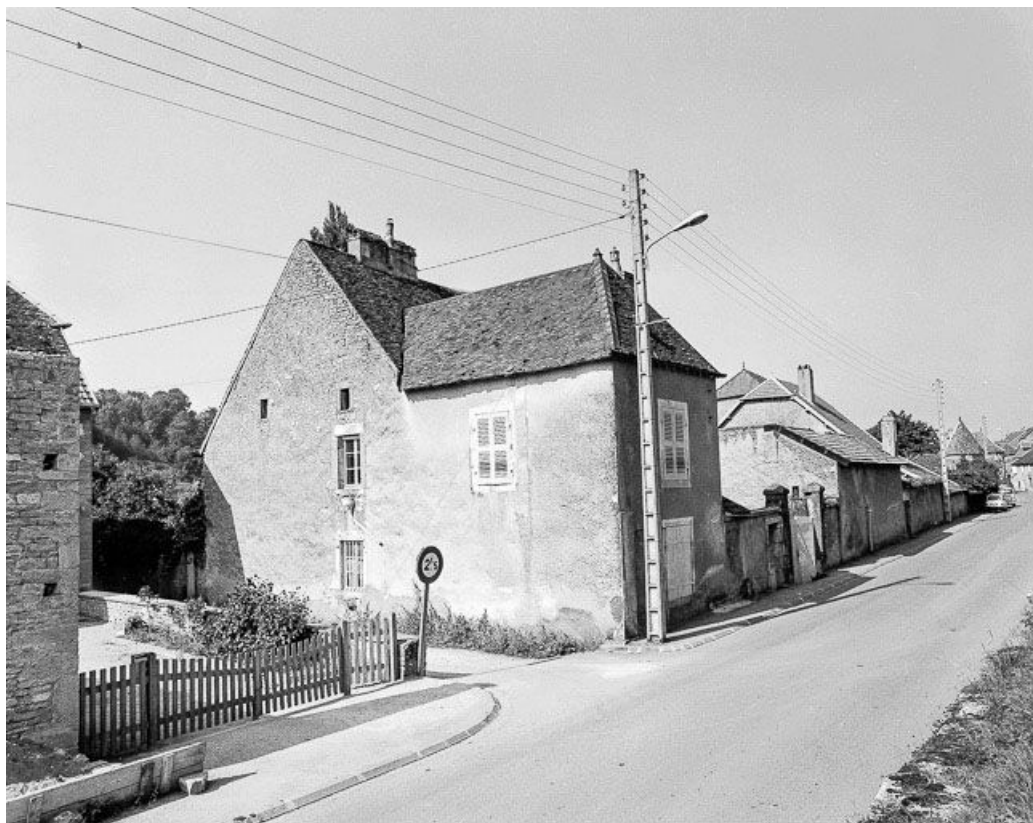
Façade latérale gauche.
