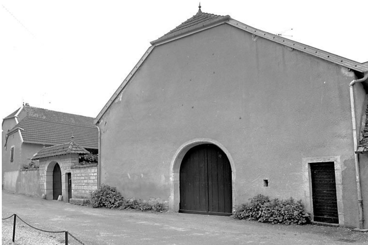
Vue d'ensemble depuis la rue.
