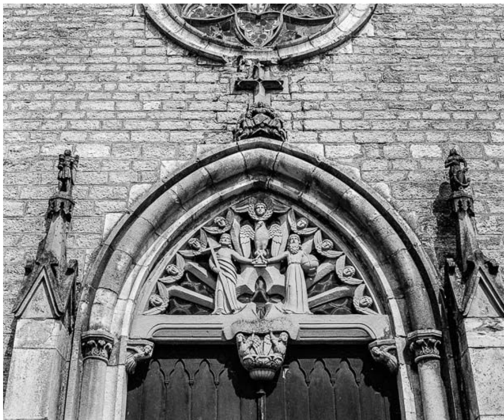
Extérieur : portail, façade antérieure, détail.
