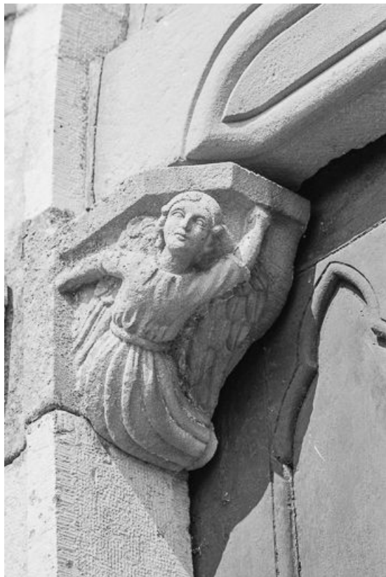
Extérieur : portail, façade antérieure, détail.
