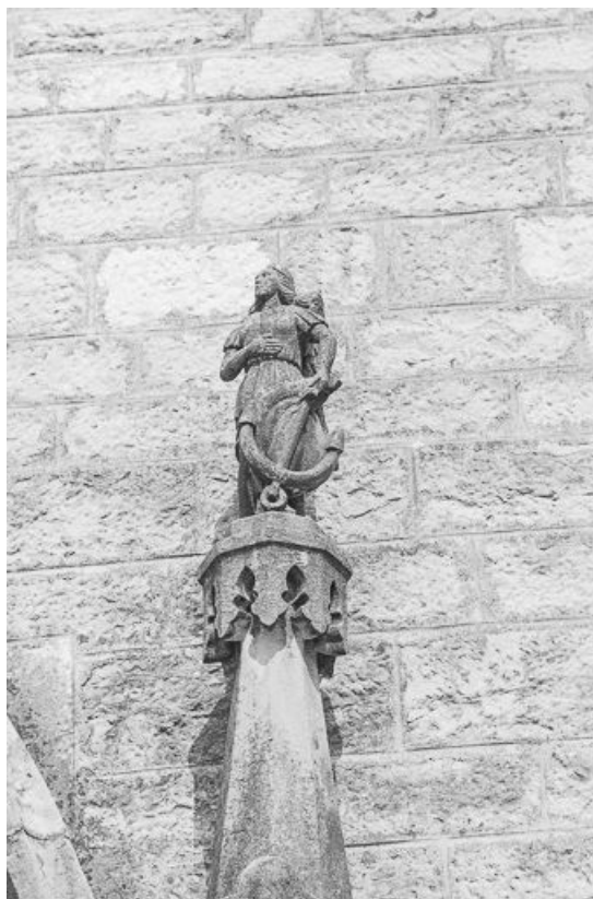
Extérieur : portail, façade antérieure, détail.
