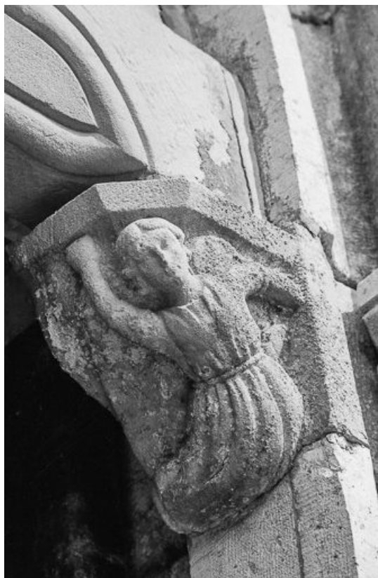
Extérieur : portail, façade antérieure, détail.
