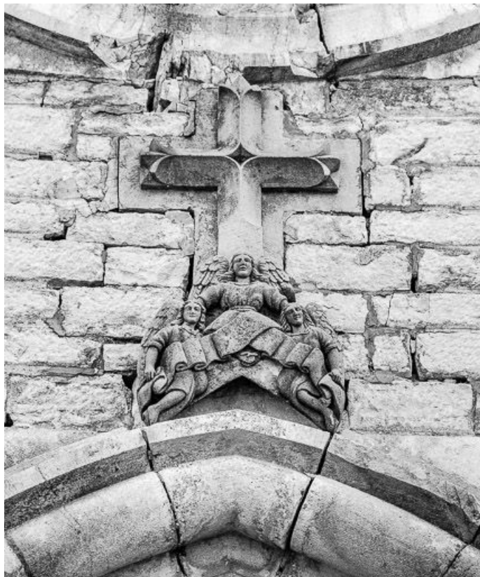
Extérieur : portail, façade antérieure, détail.
