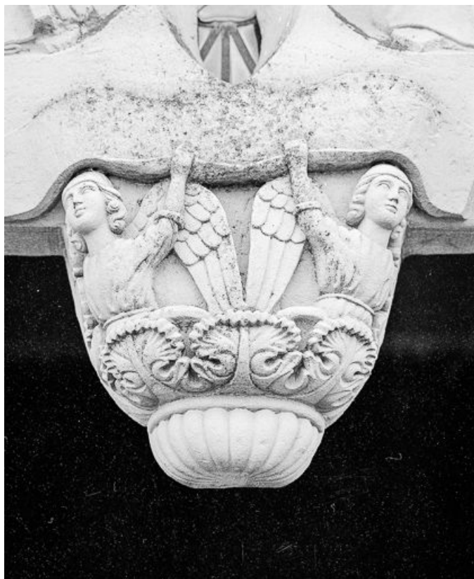
Extérieur : portail, façade antérieure, détail.
