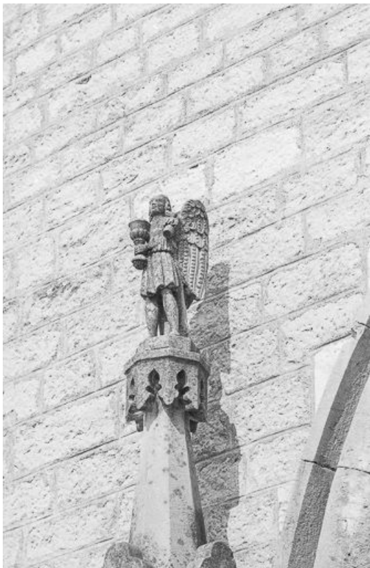
Extérieur : portail, façade antérieure, détail.
