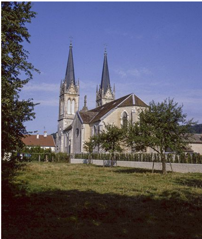
Extérieur : chevet et façade latérale droite.
