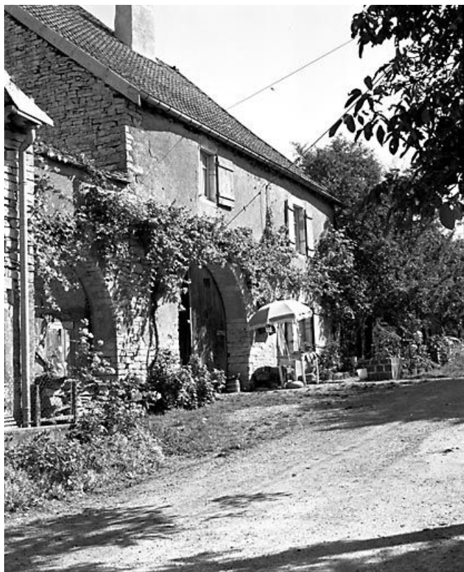
Façade antérieure de trois quarts gauche. 70, Autoreille, 1ère ferme rue des Corvées
