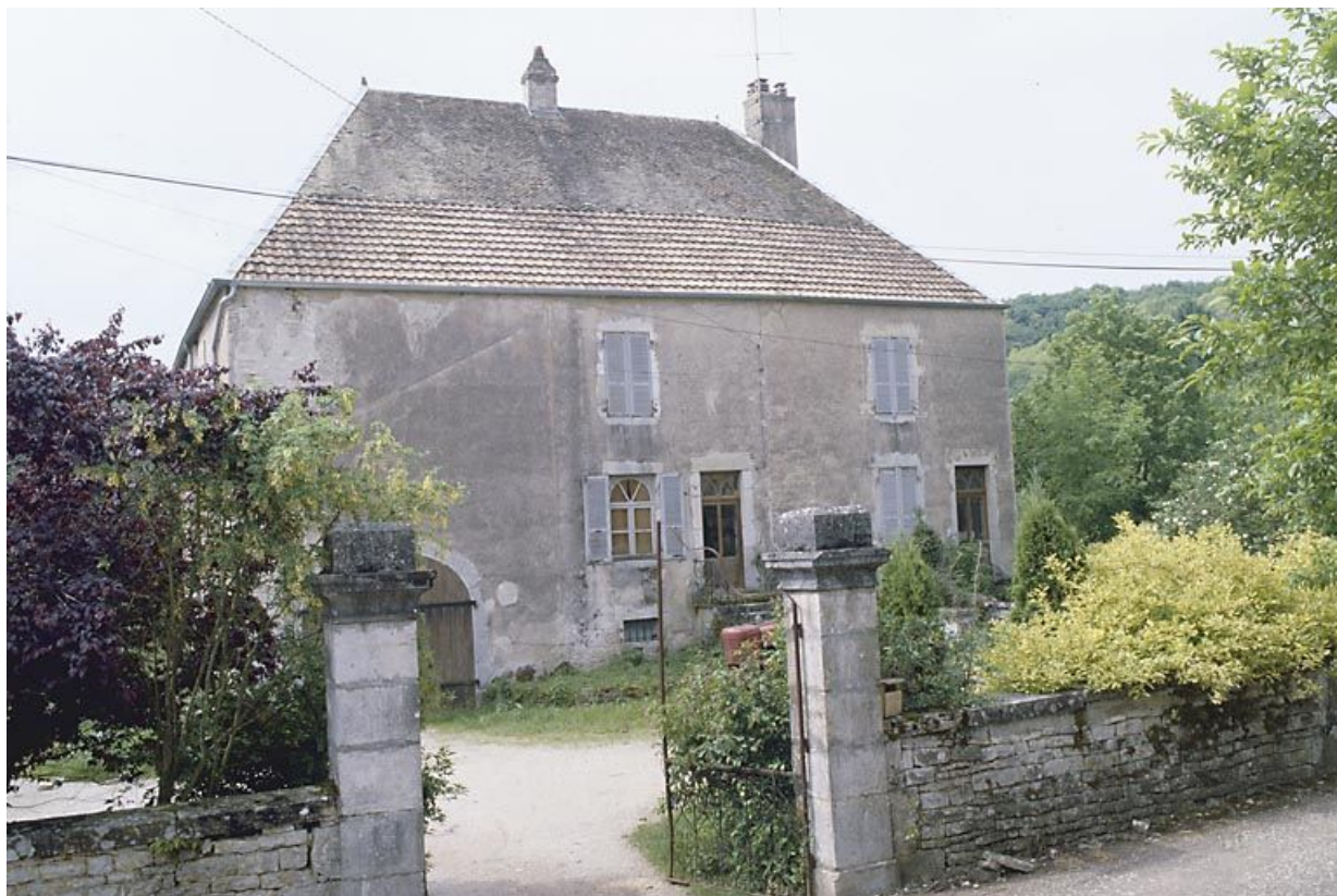
Façade antérieure de l'habitation.
