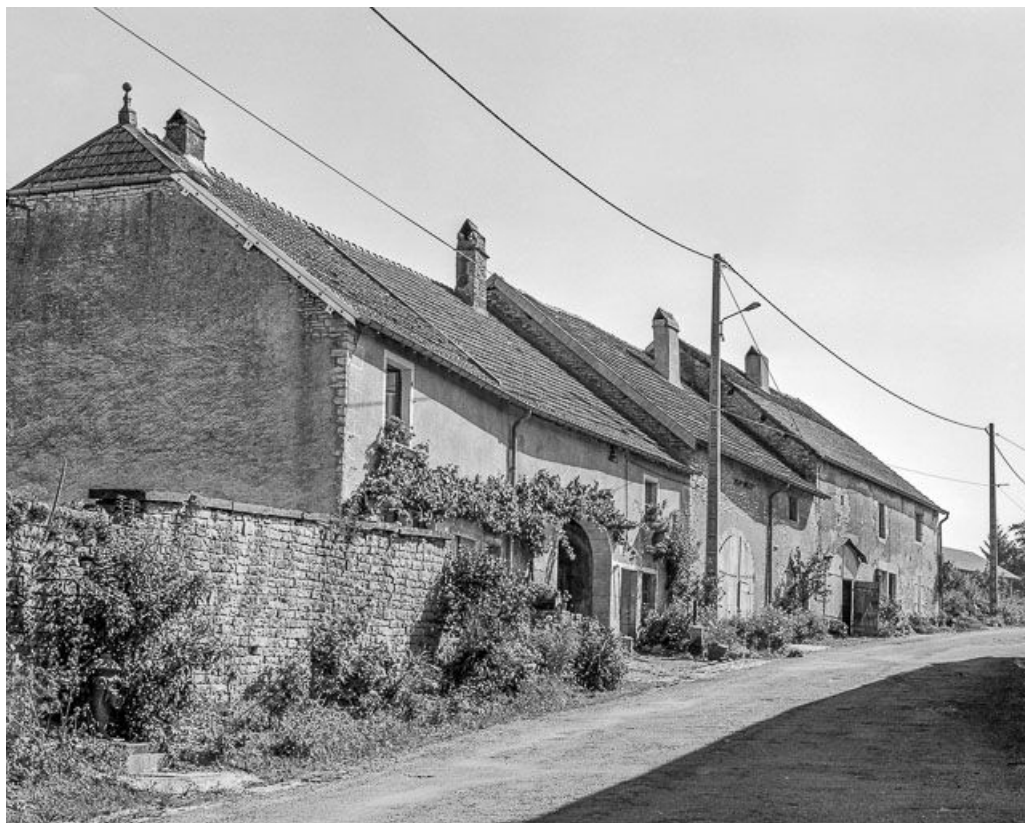
Vue d'ensemble, rue principale.
