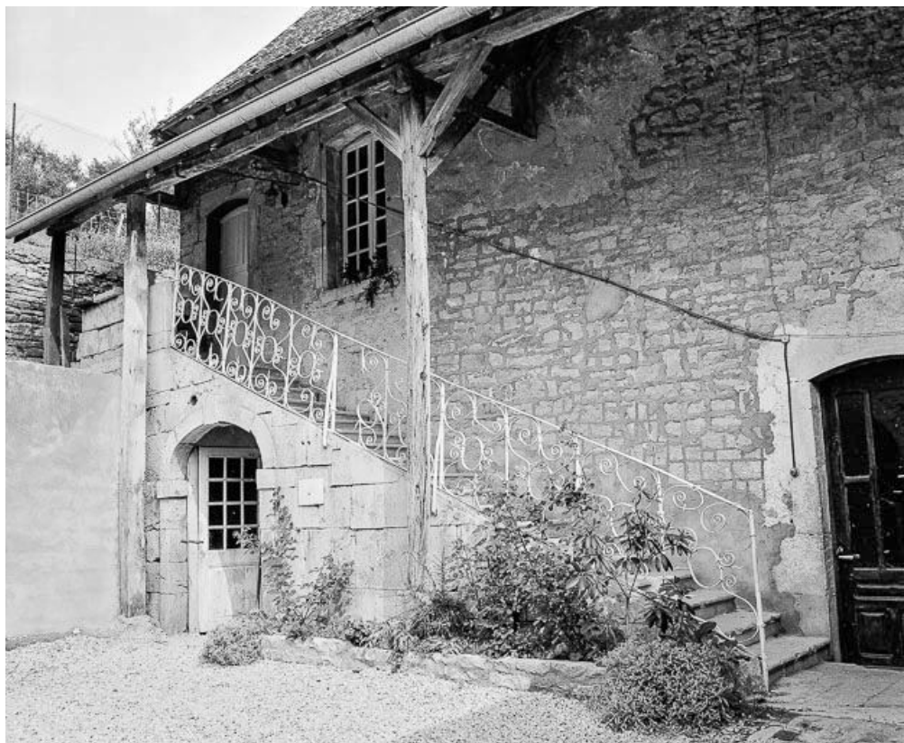
Détail de l'escalier extérieur de l'habitation.
