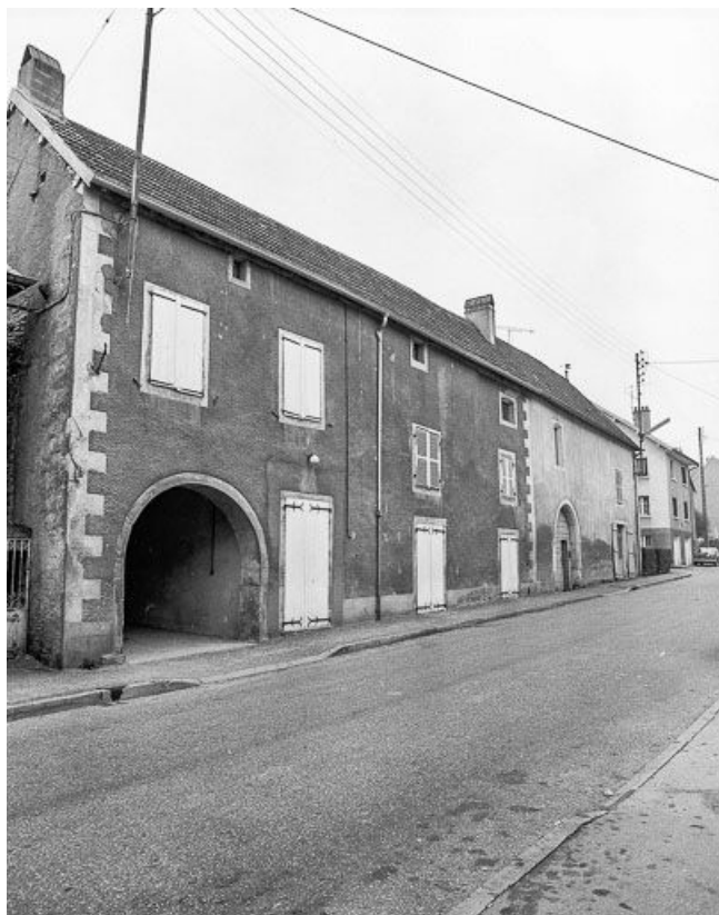
Bâtiments sur rue avec habitation sur porche vus de trois quarts gauche.
