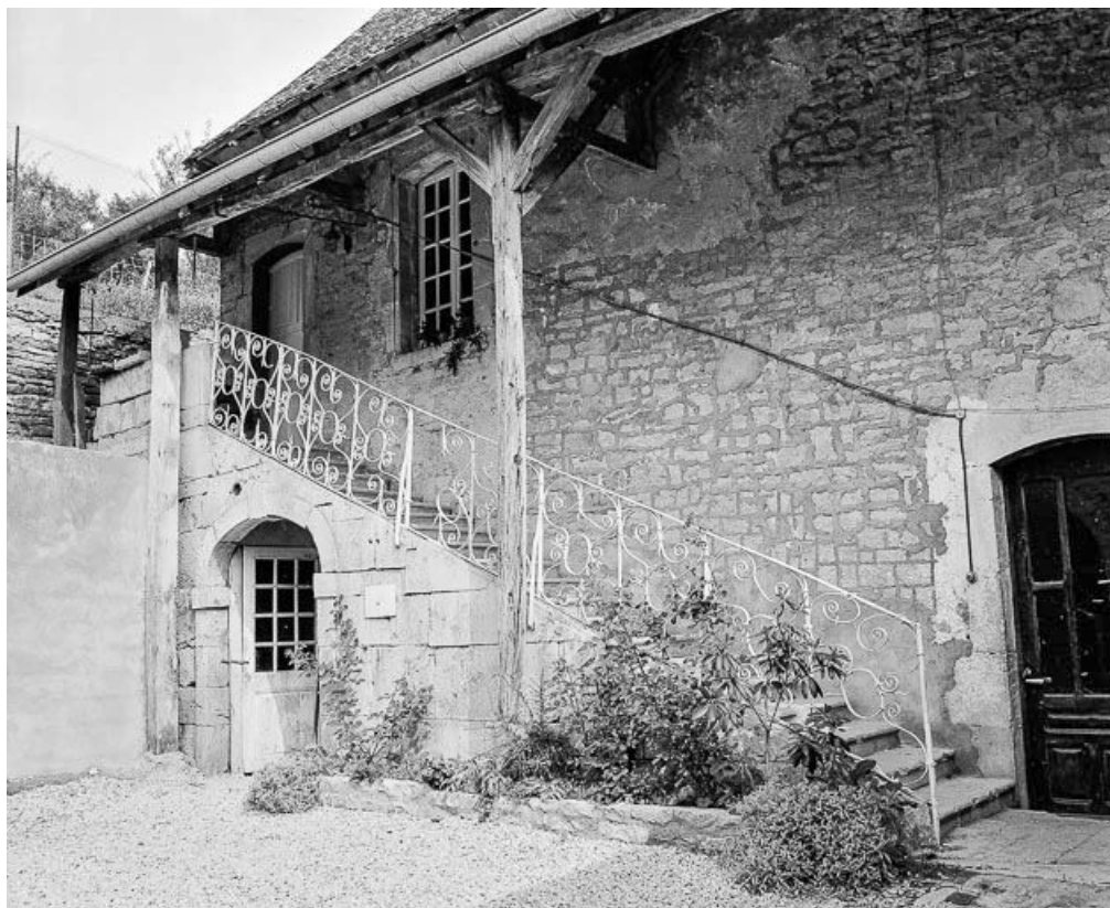
Détail de l'escalier extérieur de l'habitation.
