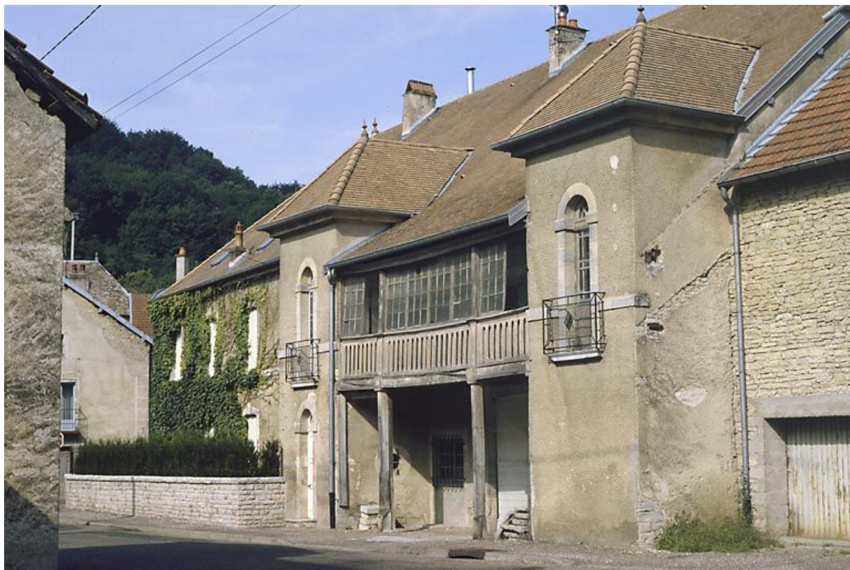
Façade latérale droite avec galerie couverte reliant deux avant-corps.
