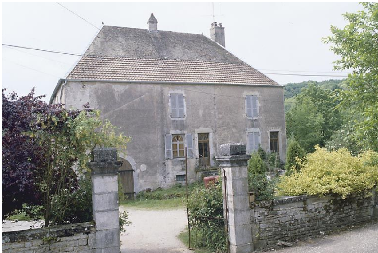
Façade antérieure de l'habitation.
