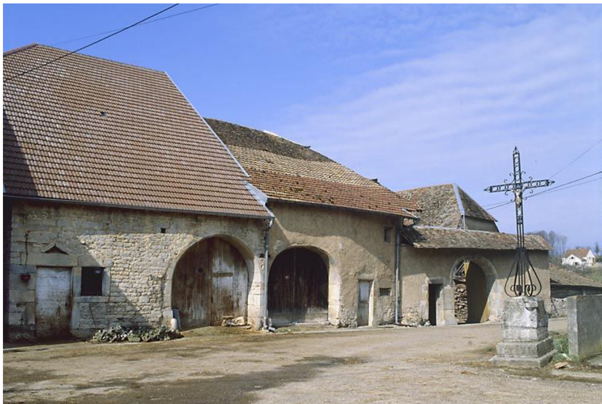
Vue d'ensemble depuis la rue.
