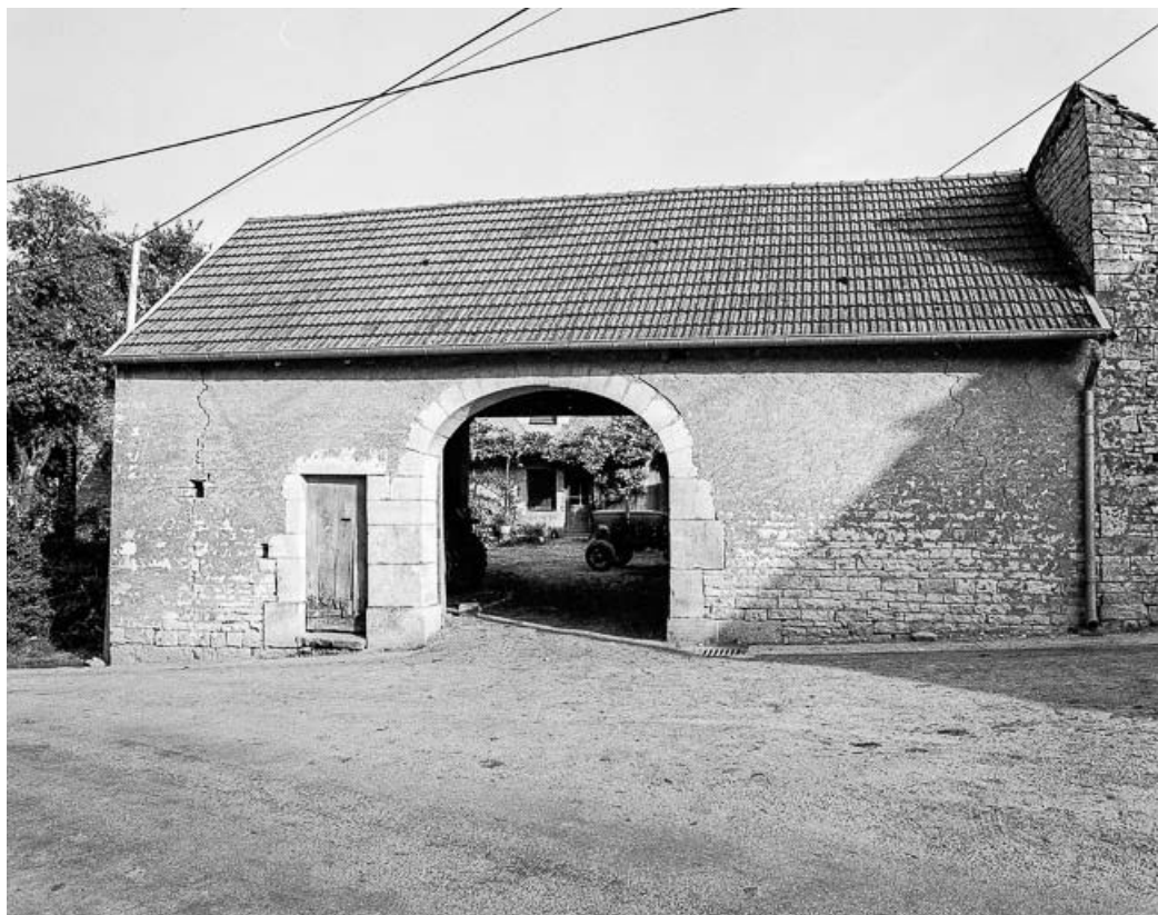
Bâtiment d'entrée sur cour.
