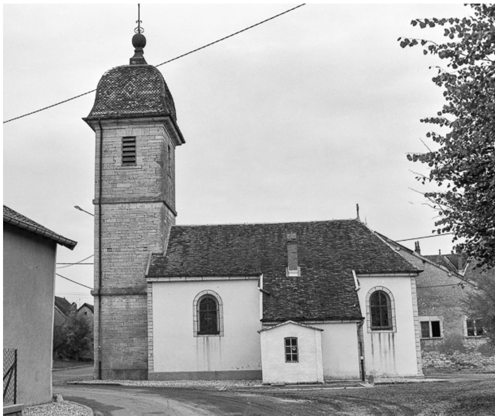
Extérieur : façade latérale droite. 70, Vregille
