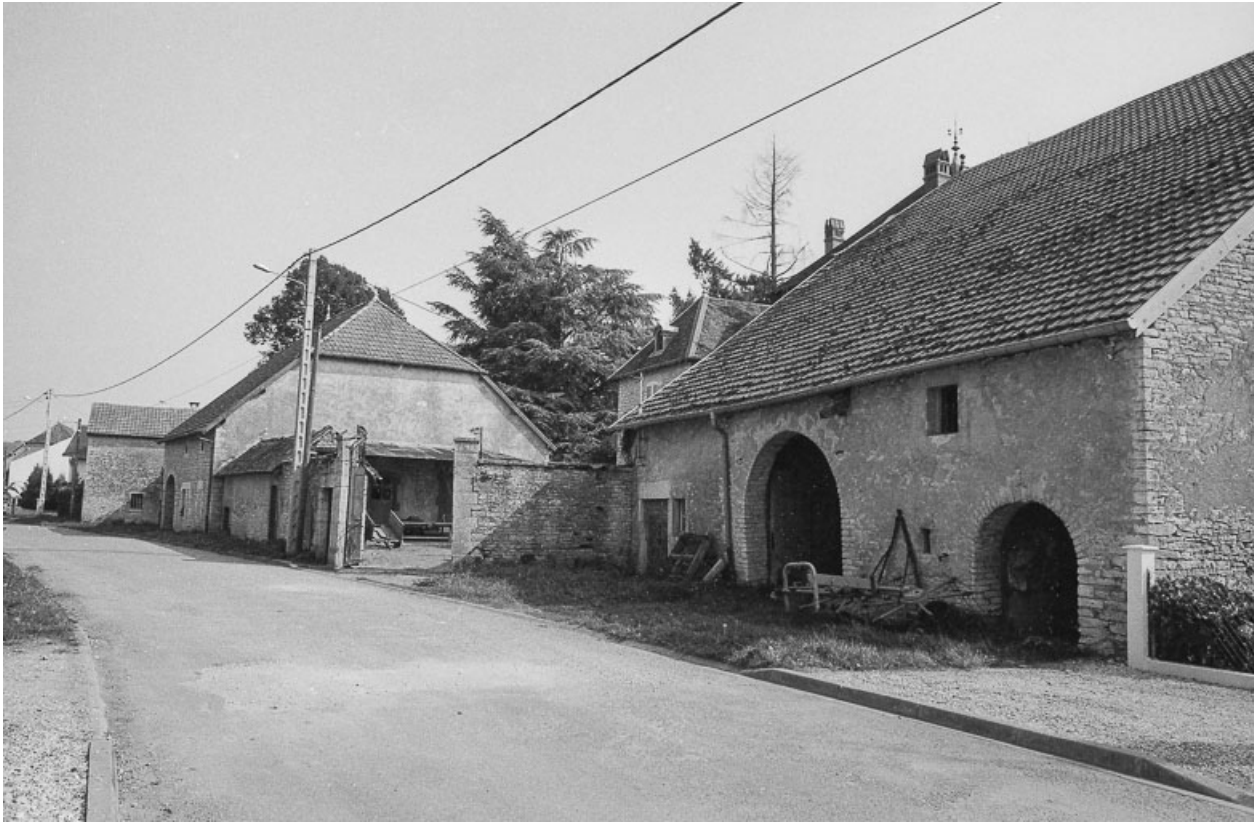
Vue d'ensemble de trois quarts droit. 70, Vregille chemin rural du Pré Simon
