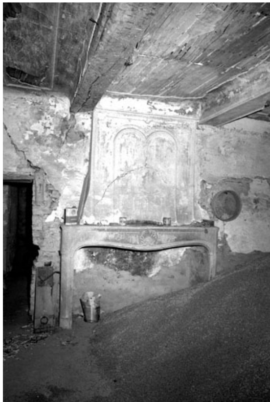
Vue intérieure : cheminée.
