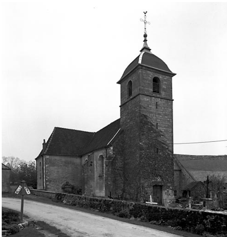
Vue du clocher-porche et de la façade latérale gauche.
