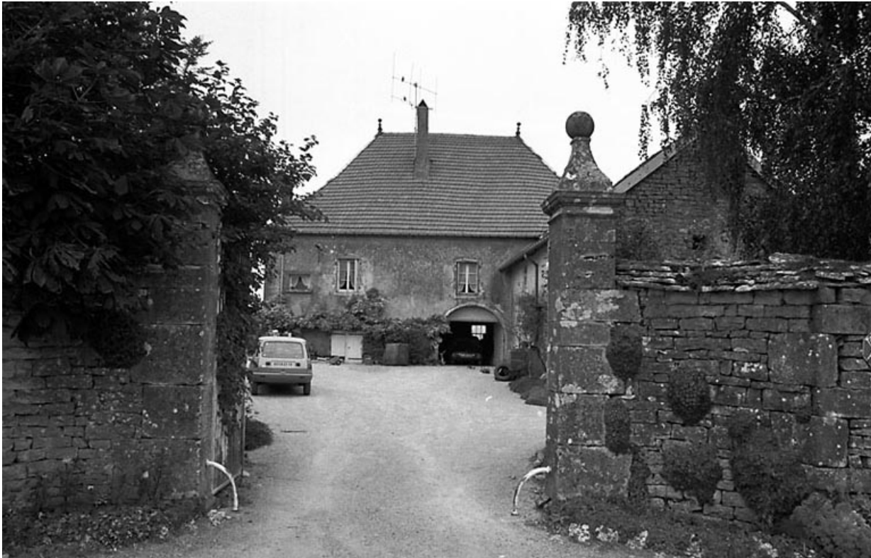
Vue de l'habitation.
