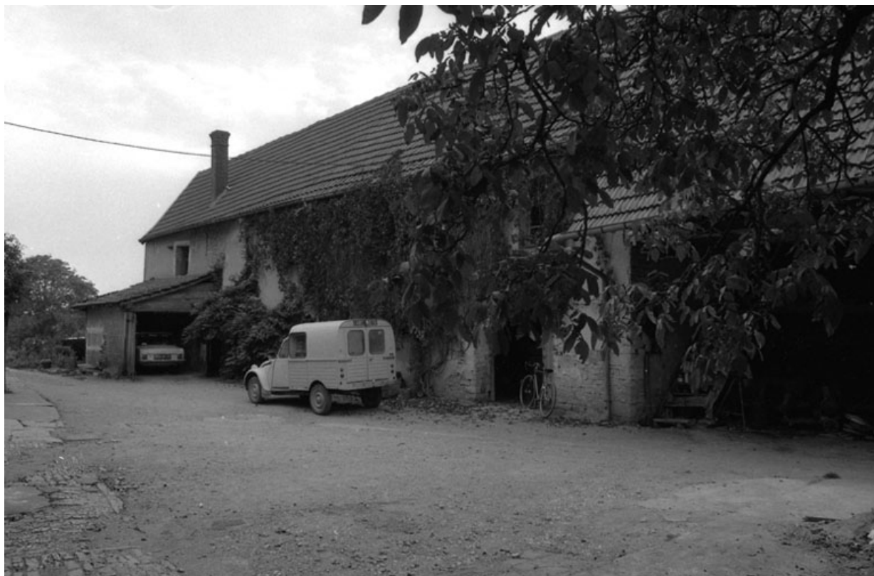
Bâtiment de droite : façade sur cour.
