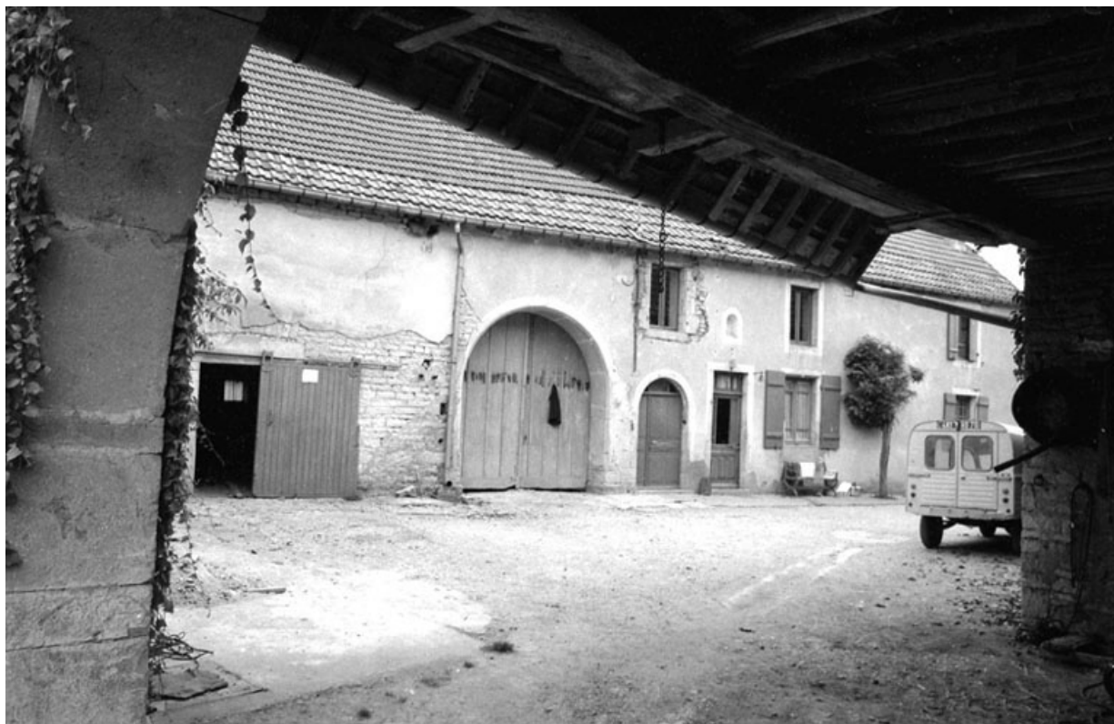
Bâtiment de gauche : façade sur cour. 70, Tromarey impasse de l' Eglise
