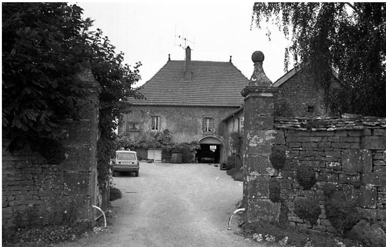
Vue de l'habitation.
