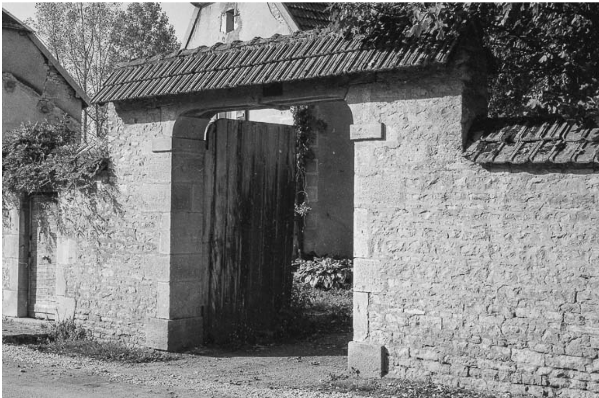
Détail : portail d'entrée.
