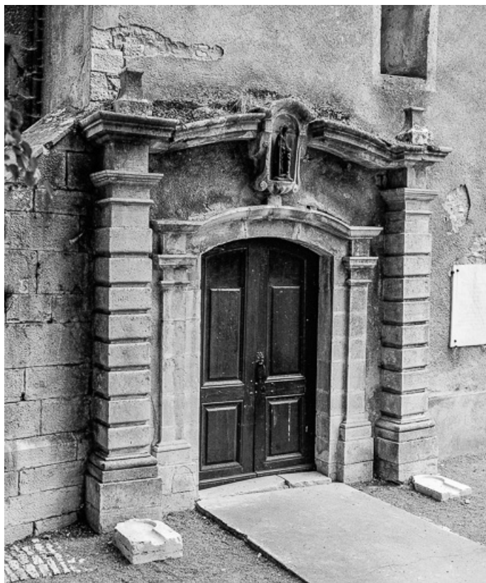
Portail d'entrée vue de trois quarts gauche.
