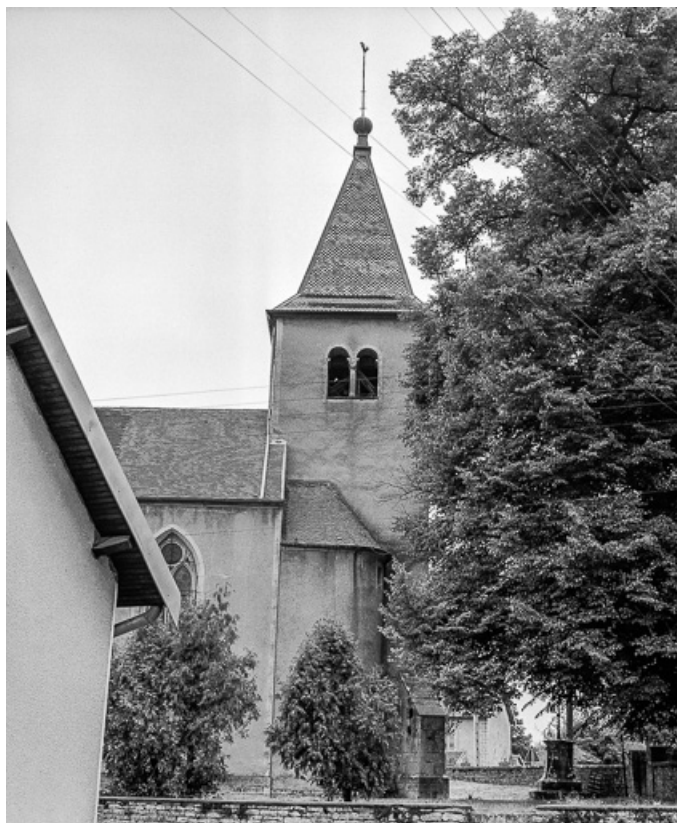
Clocher : façade gauche.
