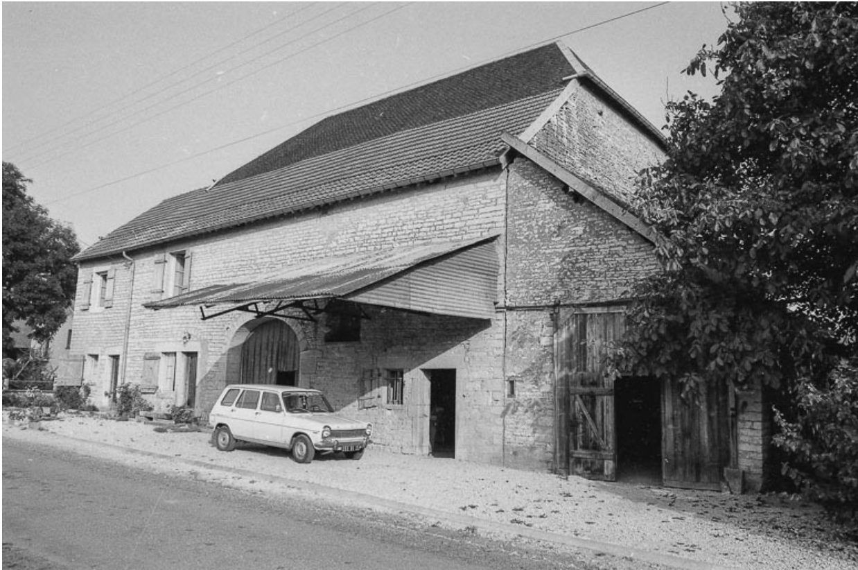
Vue d'ensemble (depuis la droite).
