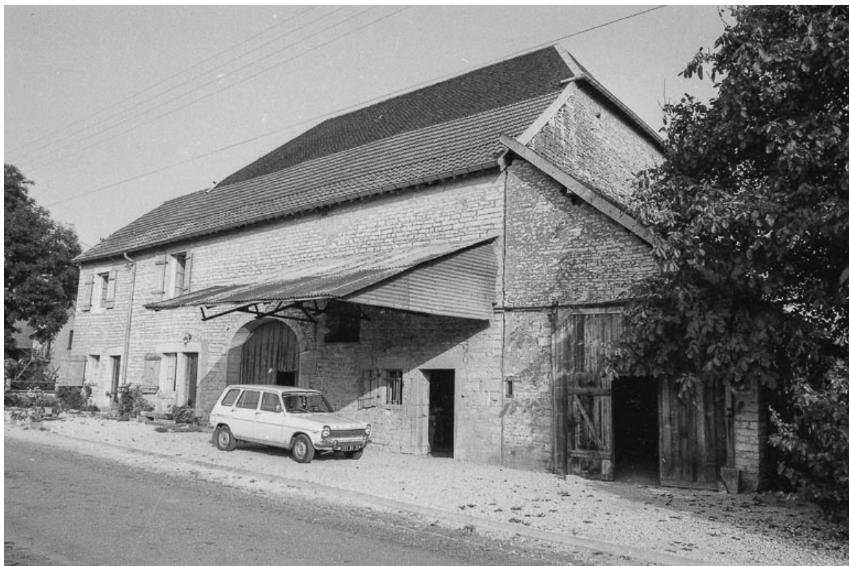
Vue d'ensemble (depuis la droite).
