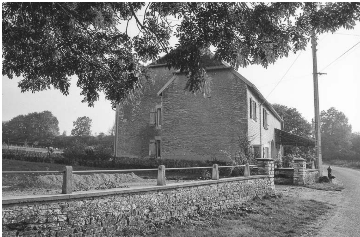
Vue d'ensemble (depuis la gauche).
