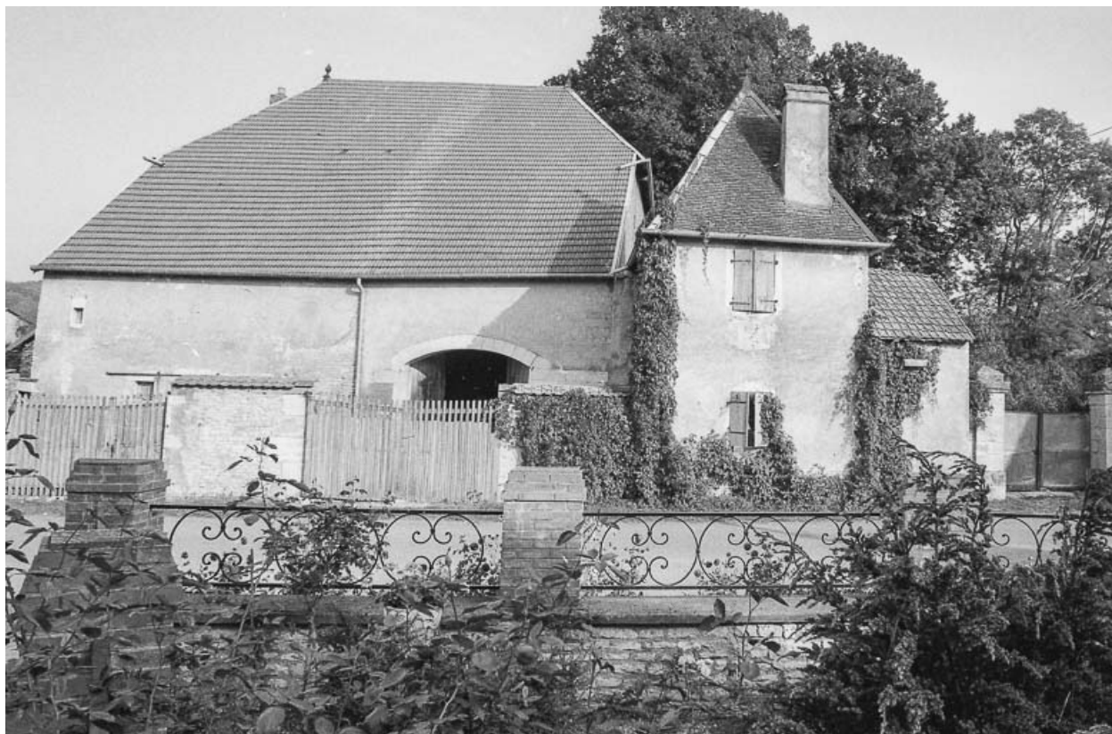
Maison cadastrée 1960 AC 98 : façade sur rue. 70, Sornay
