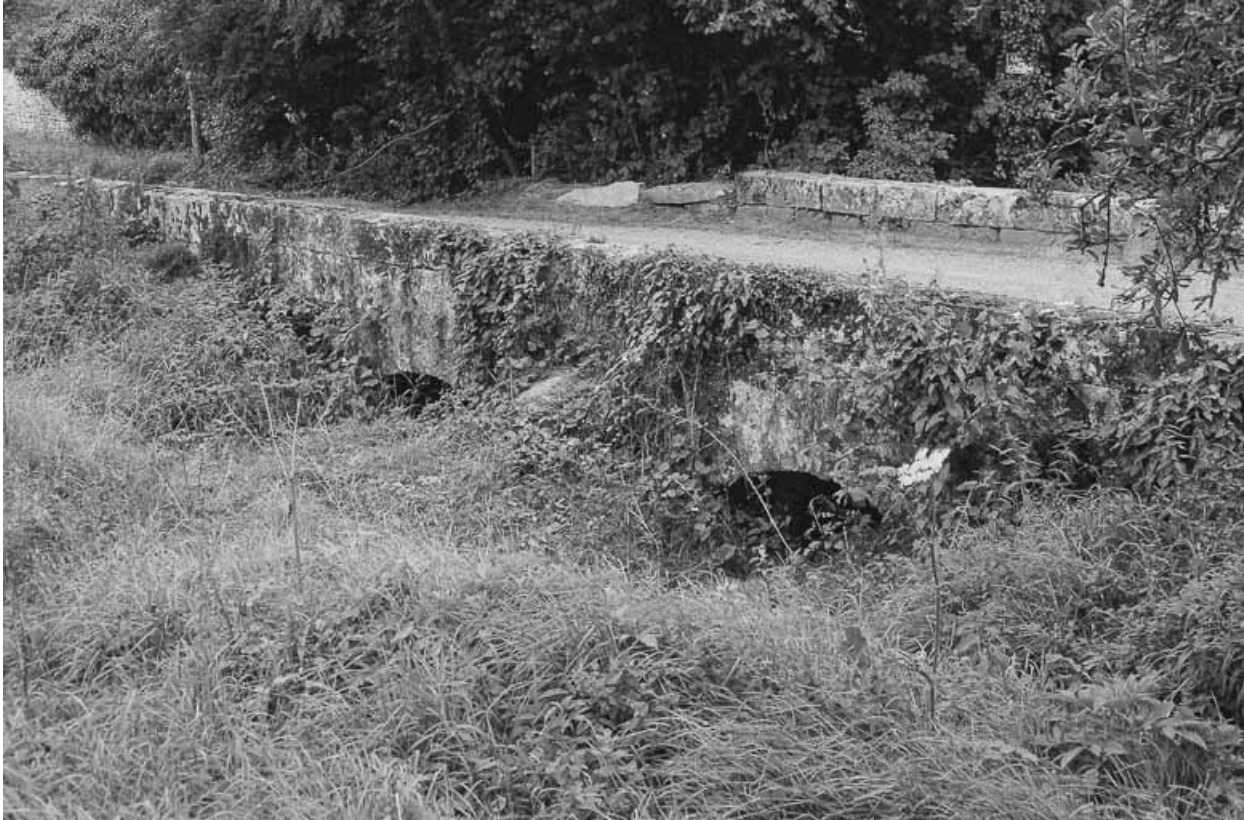
Fontaine et lavoir détruit situés dans le prolongement de la rue du Touillon : détail du lavoir. 70, Pin
