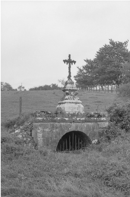
Fontaine située rue du Touillon (dans un pré après les maisons) : vue d'ensemble. 70, Pin
