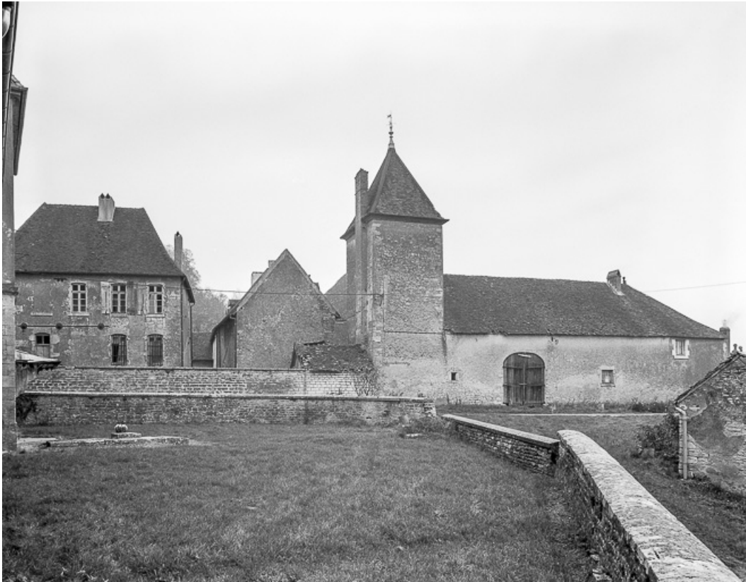
Vue d'ensemble de la partie gauche.
