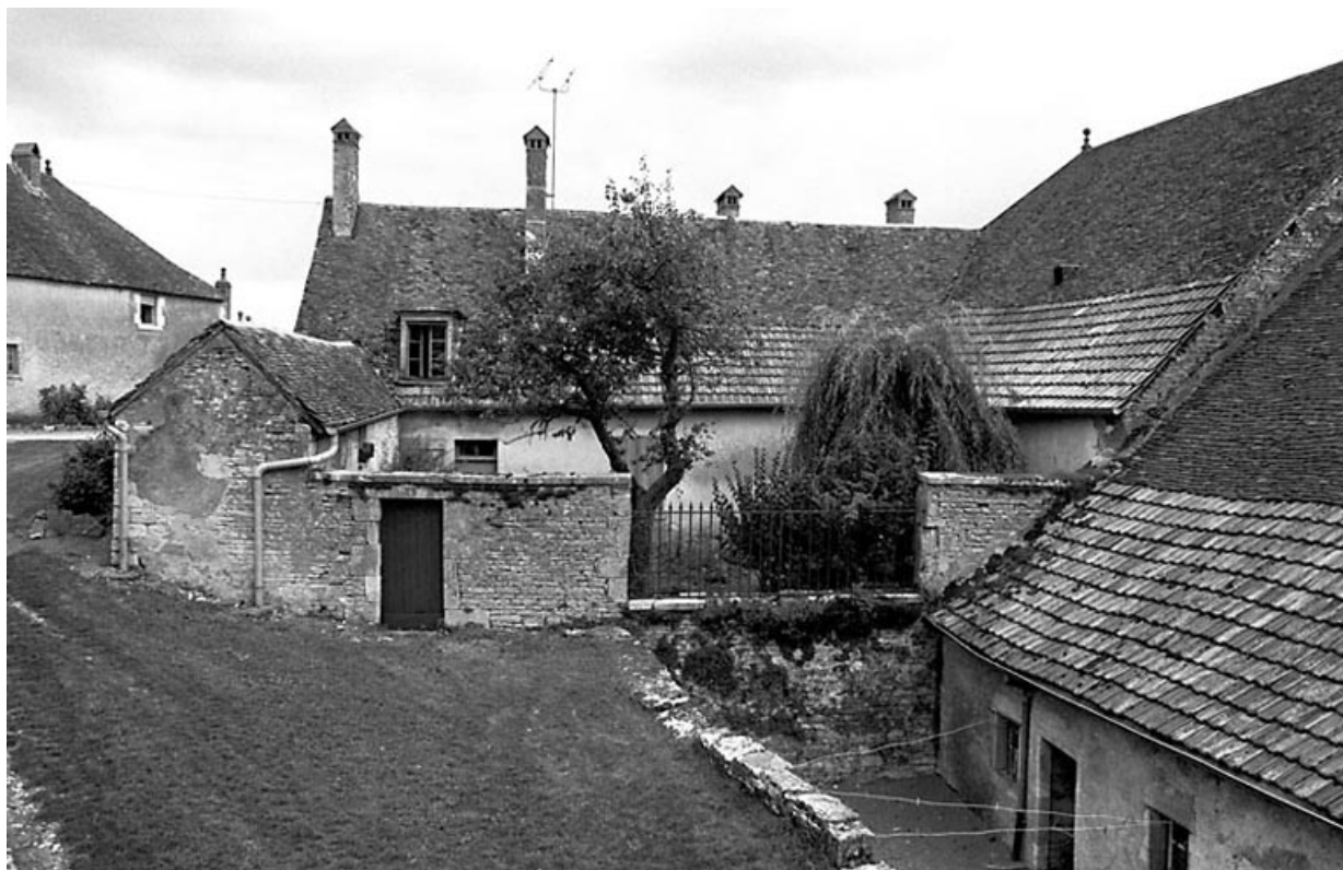
Façade sur cour.
