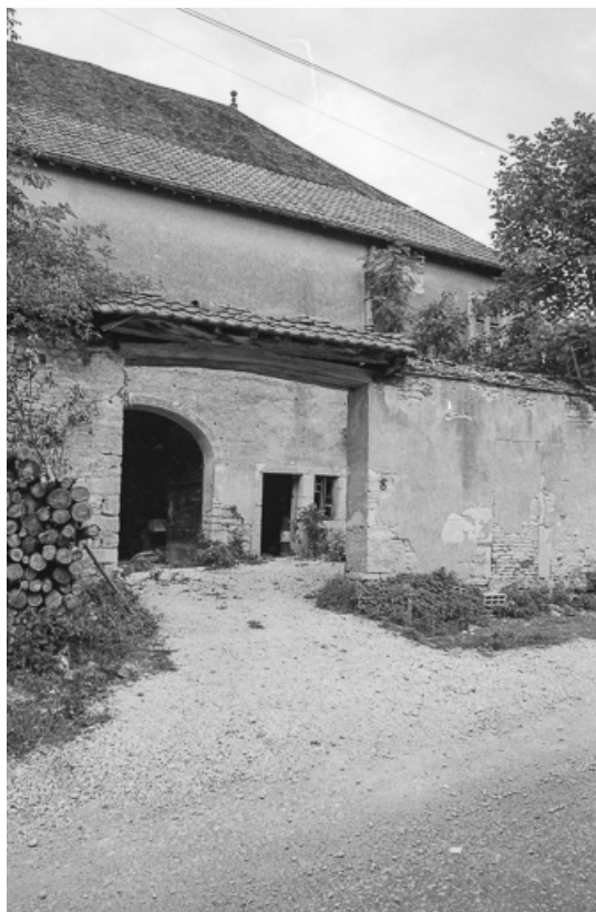
Façade latérale droite.
