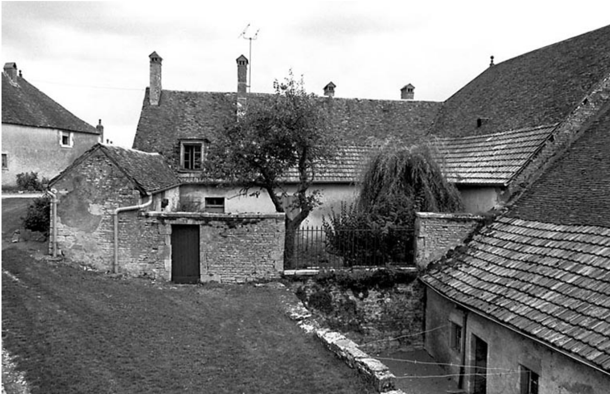
Façade sur cour.
