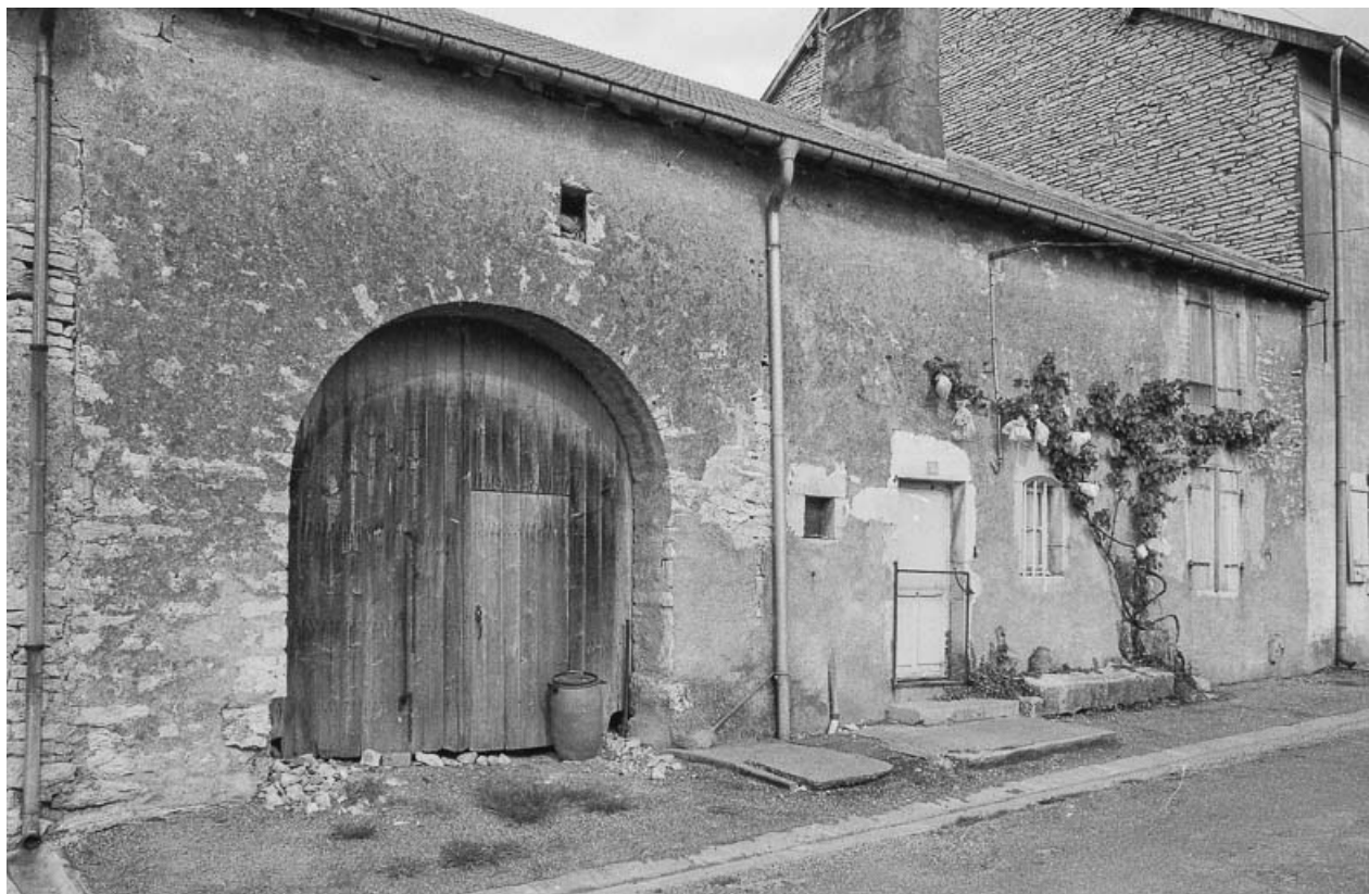
Ferme cadastrée 1971 AB 149, située rue des Douches : façade antérieure. 70, Pin
