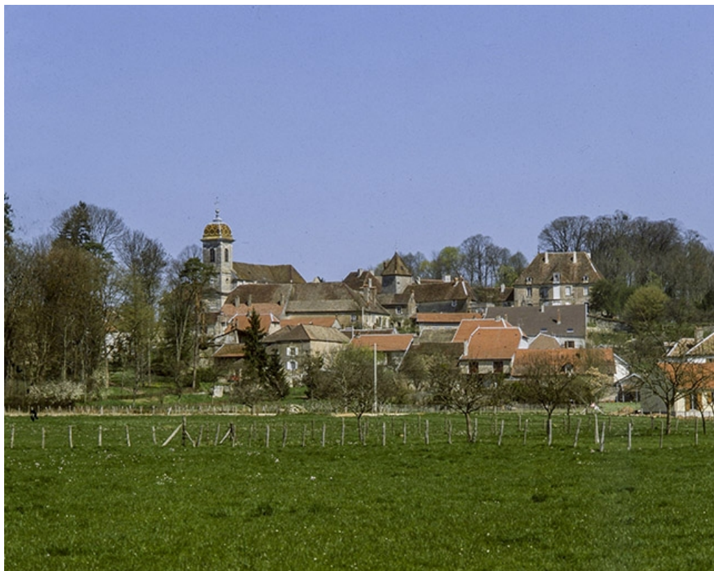
Vue d'ensemble depuis la route de Brussey. 70, Pin
