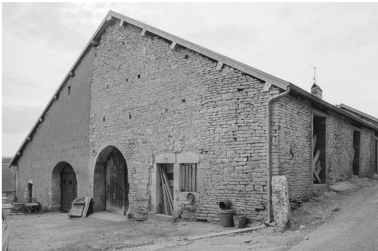
Ferme située ruelle des Voeux : façade antérieure. 70, Pin
