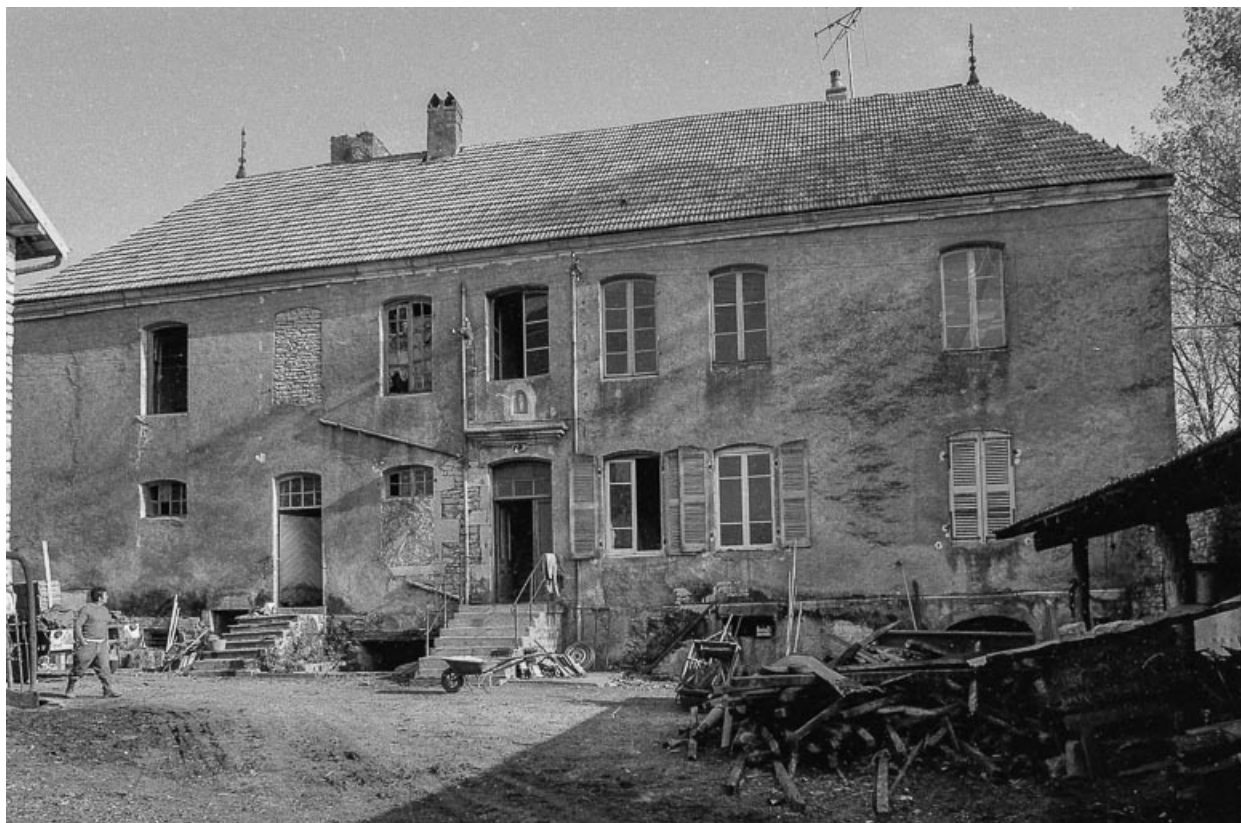
Façade antérieure sur cour.
