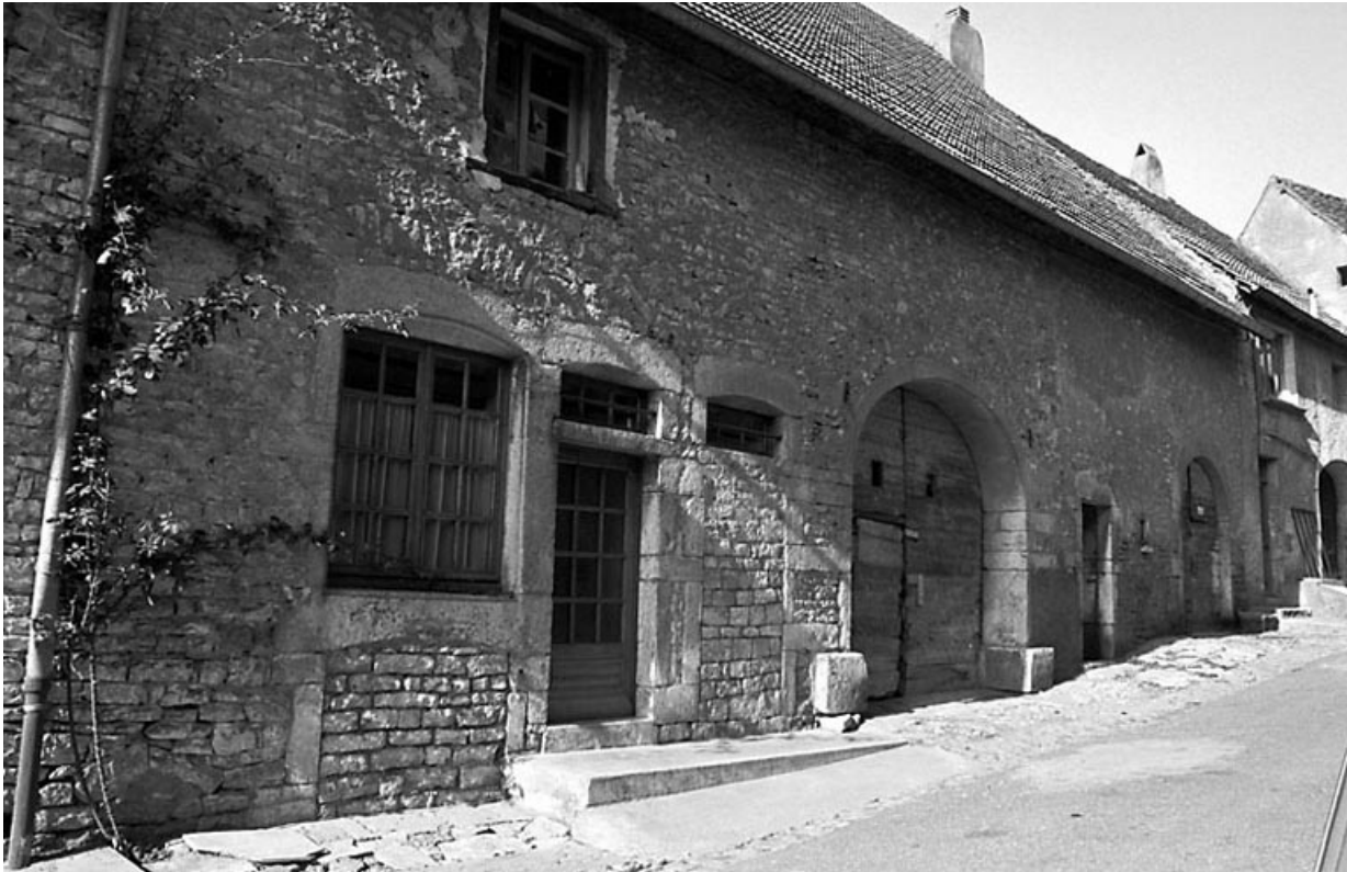
Façade antérieure vue de trois quarts gauche. 70, Marnay
