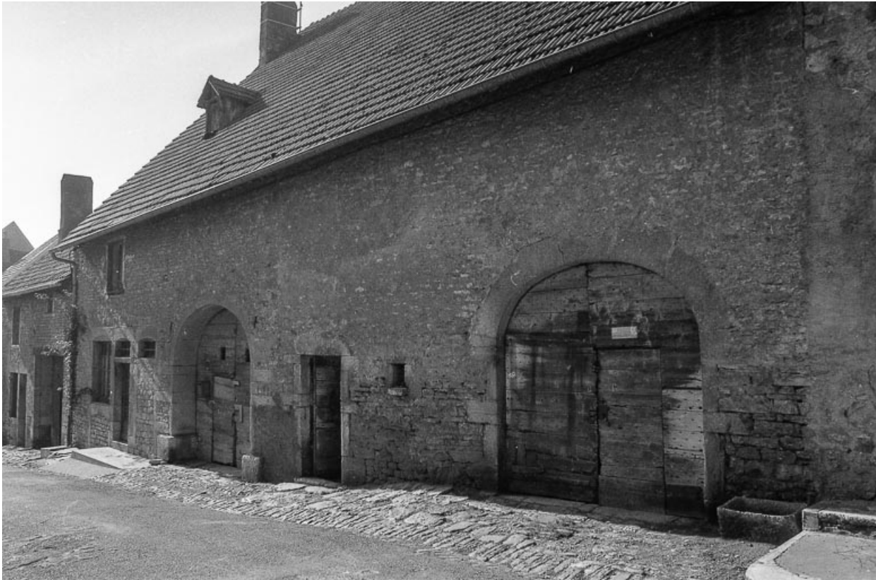
Façade antérieure vue de trois quarts droit. 70, Marnay rue Bizot
