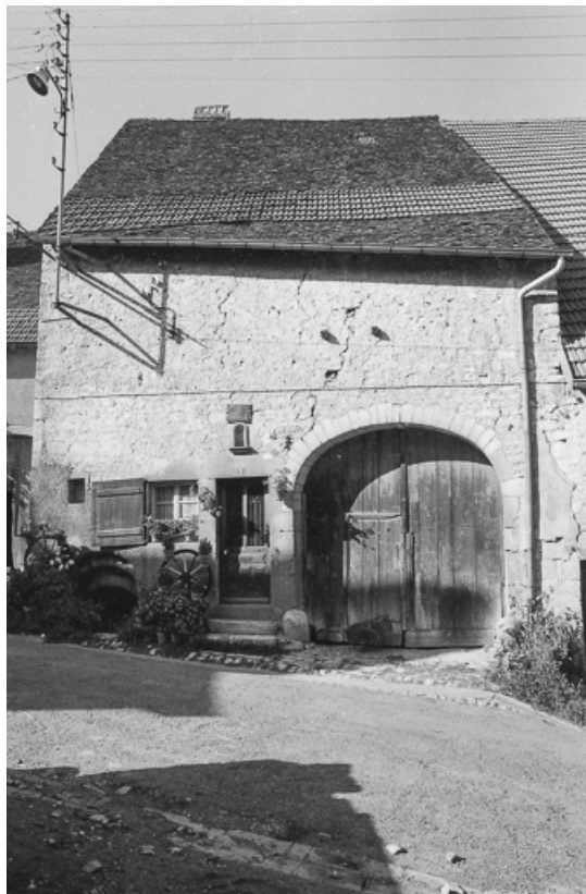
Façade antérieure, vue de face.
