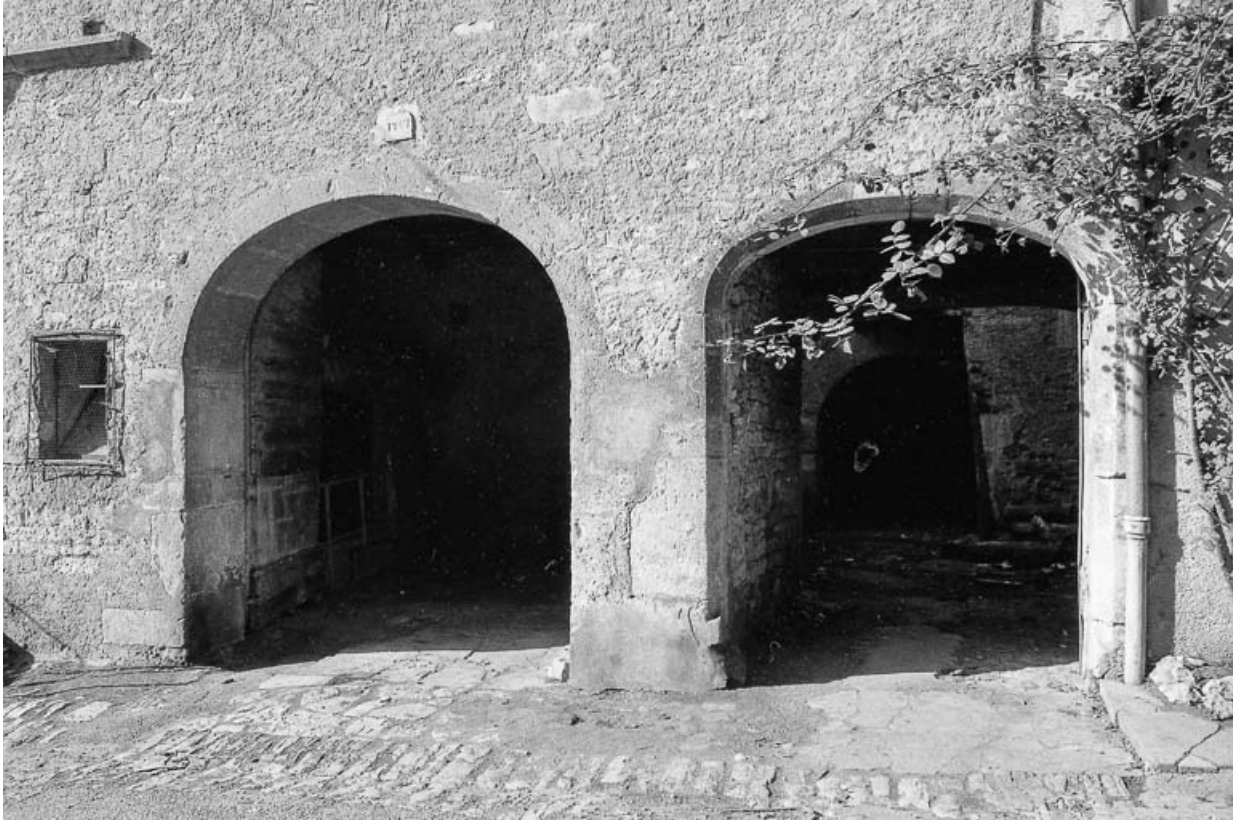
Détail de la façade sur rue.
