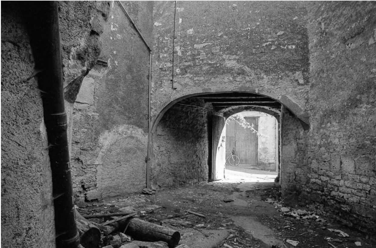
Vue du porche depuis la cour.
