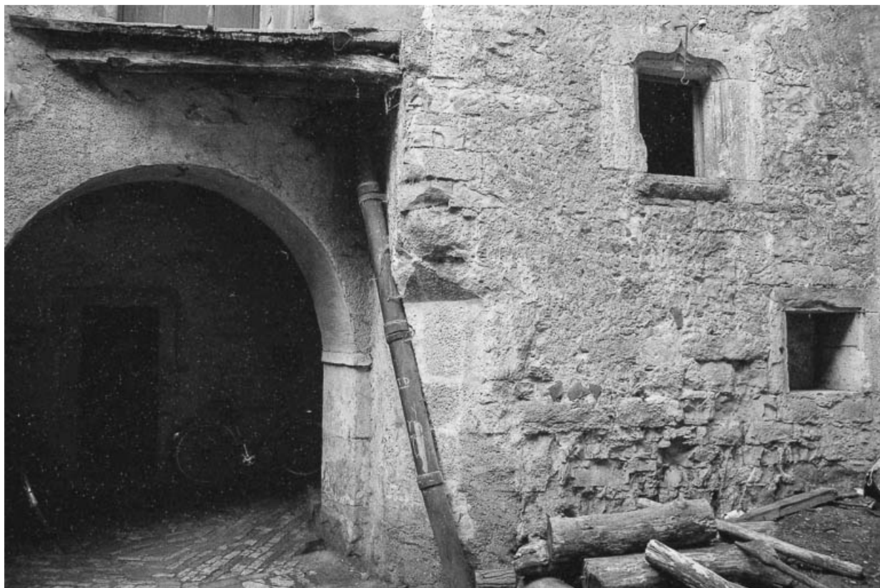
Accès à la tour d'escalier.
