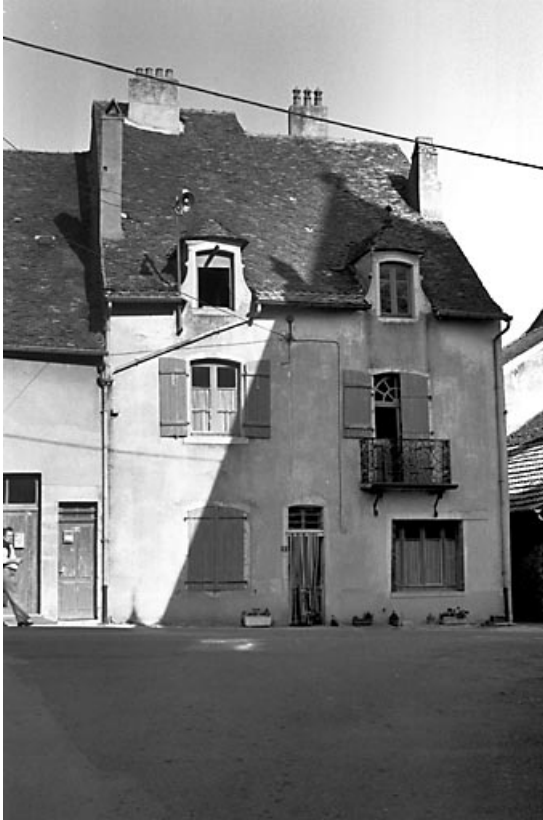
Façade sur rue. 70, Marnay
