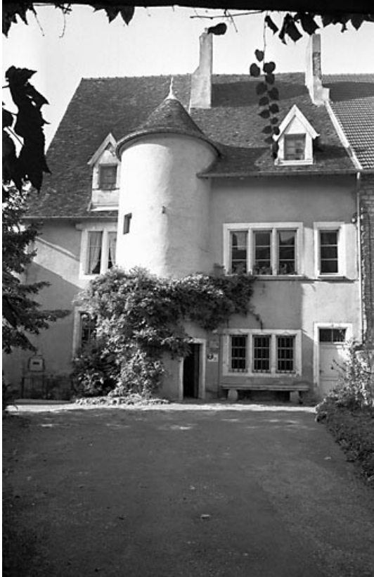
Façade antérieure sur cour : partie gauche. 70, Marnay rue de l' Eglise
