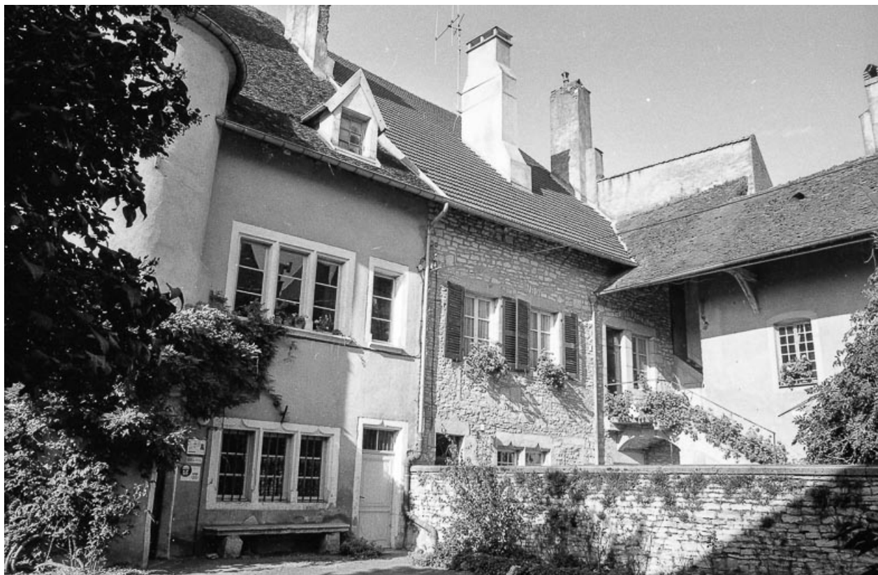
Façade antérieure sur cour.
