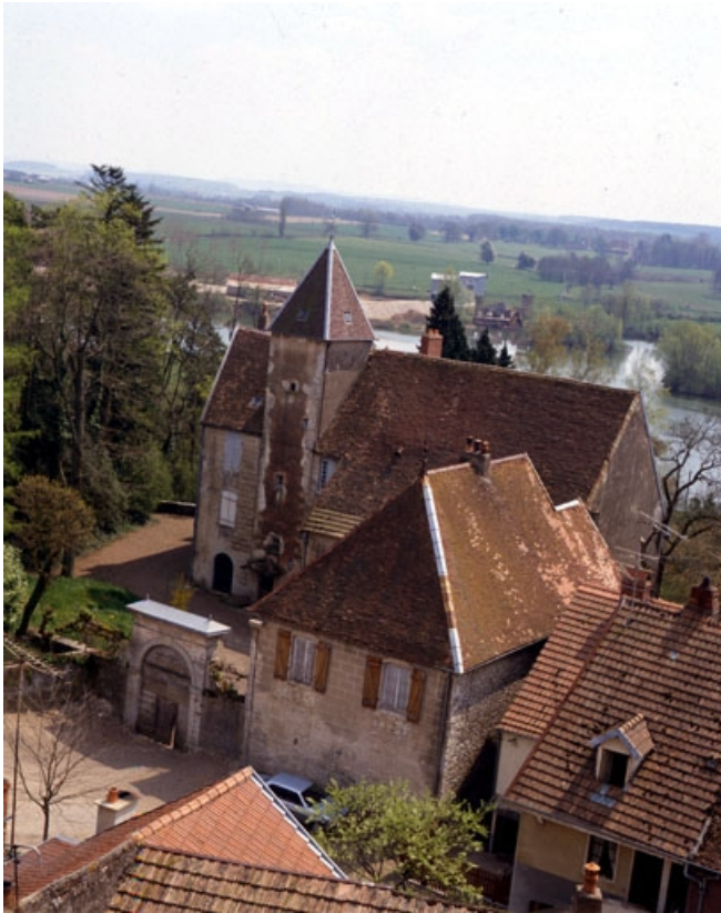
Vue d'ensemble depuis le clocher de l'église.
