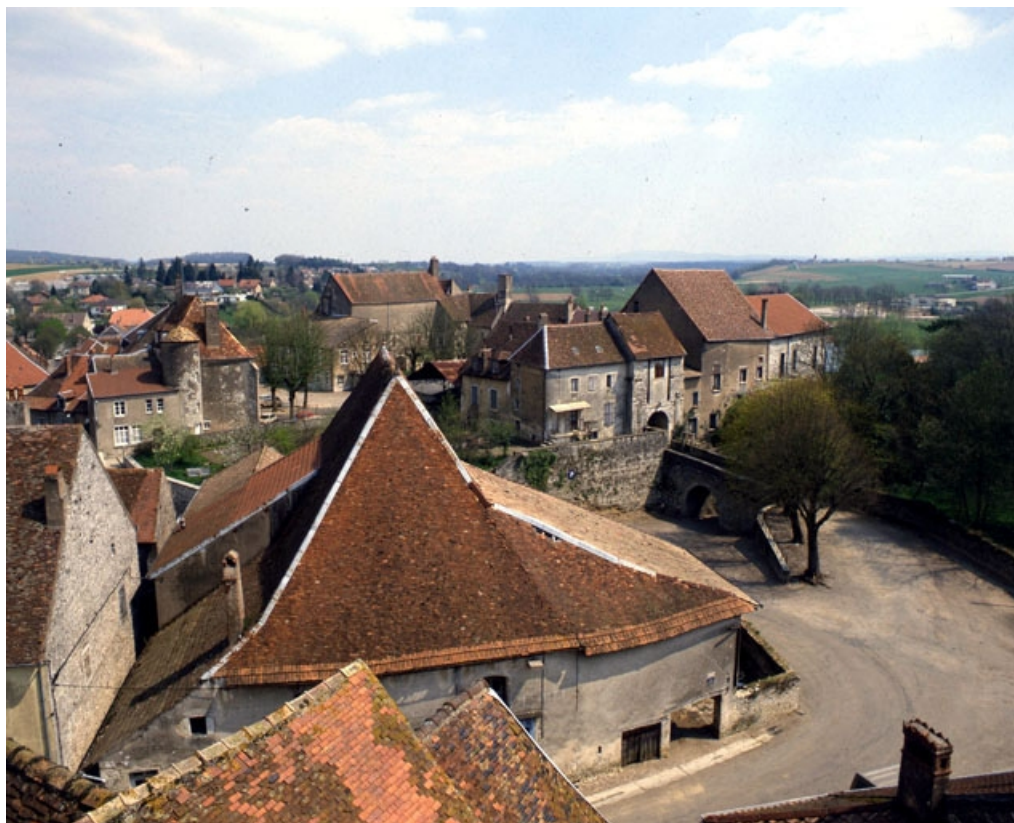
Vue d'ensemble depuis le clocher de l'église.
