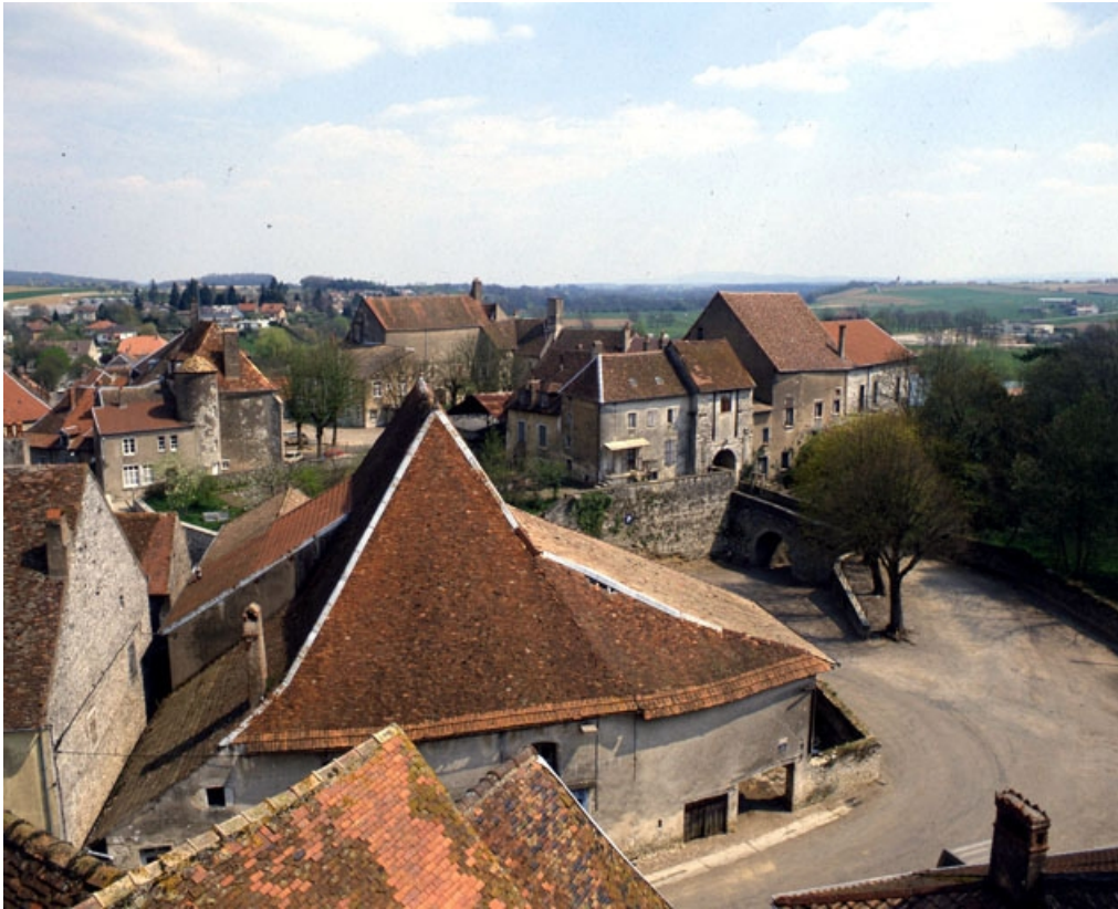
Vue d'ensemble depuis le clocher de l'église.
