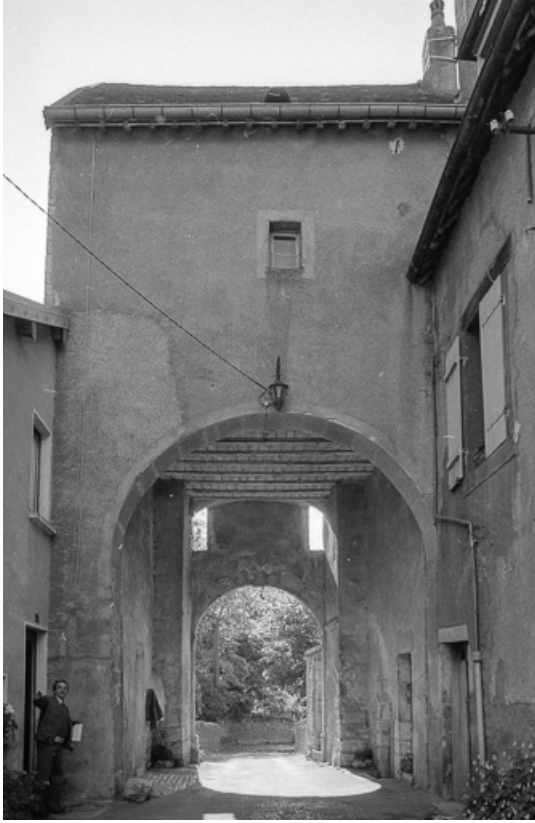
Ouvrage d'entrée : façade sur cour. 70, Marnay place Jean de Joinville
