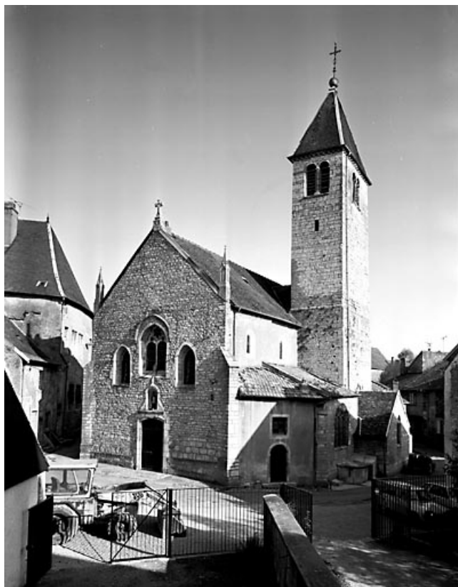
Vue des façades ouest et sud.
