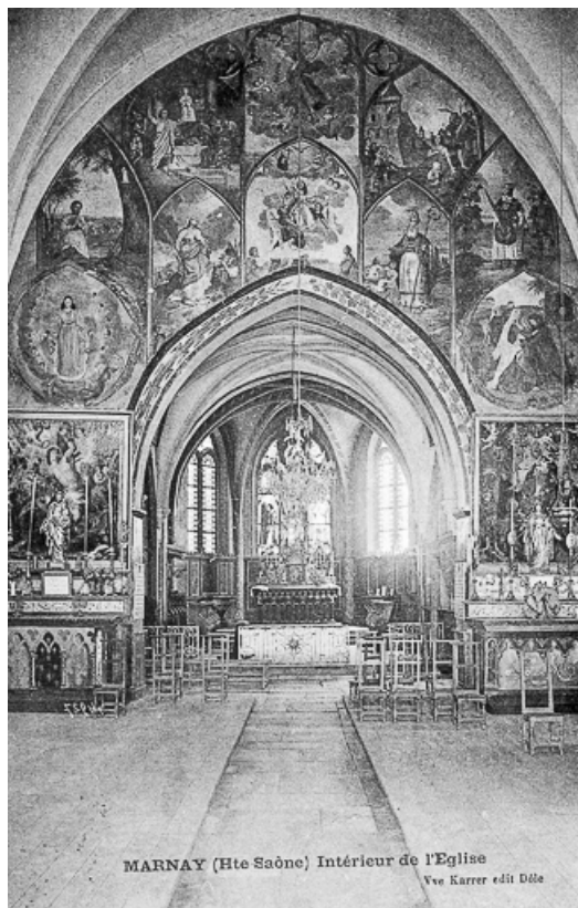
Intérieur : vue du choeur. 70, Marnay rue de l' Eglise
