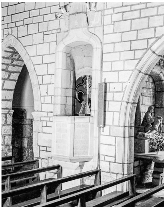
Nef : chaire à prêcher, mur droit.
