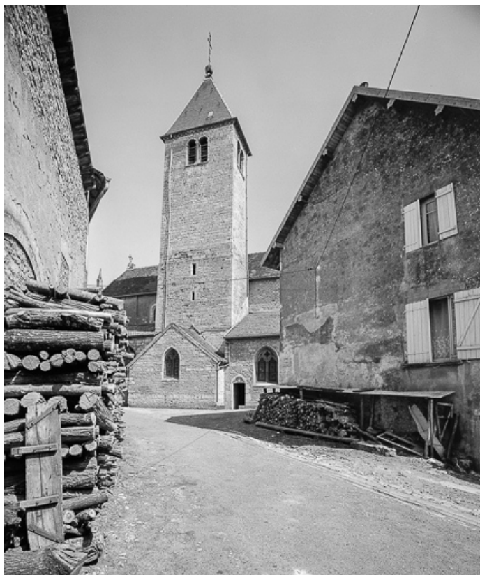
Façade latérale droite.
