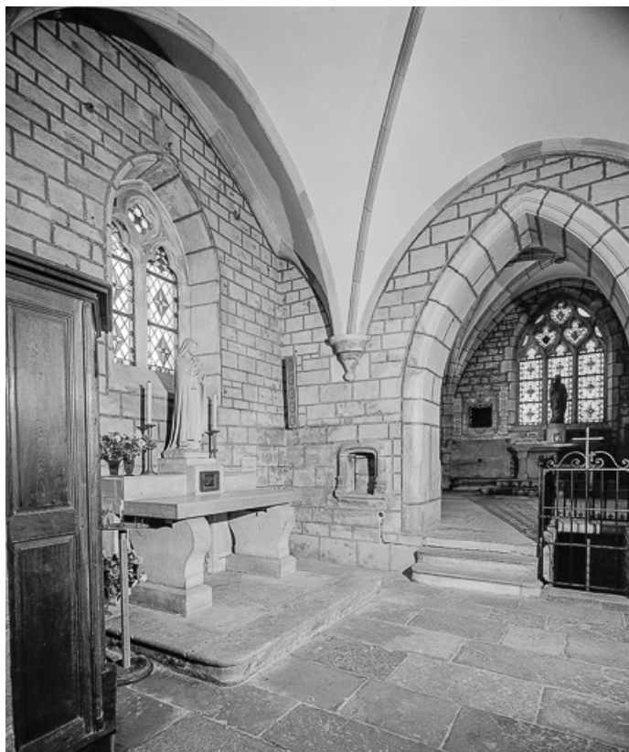
Bas côté gauche (avant la chapelle gauche).
