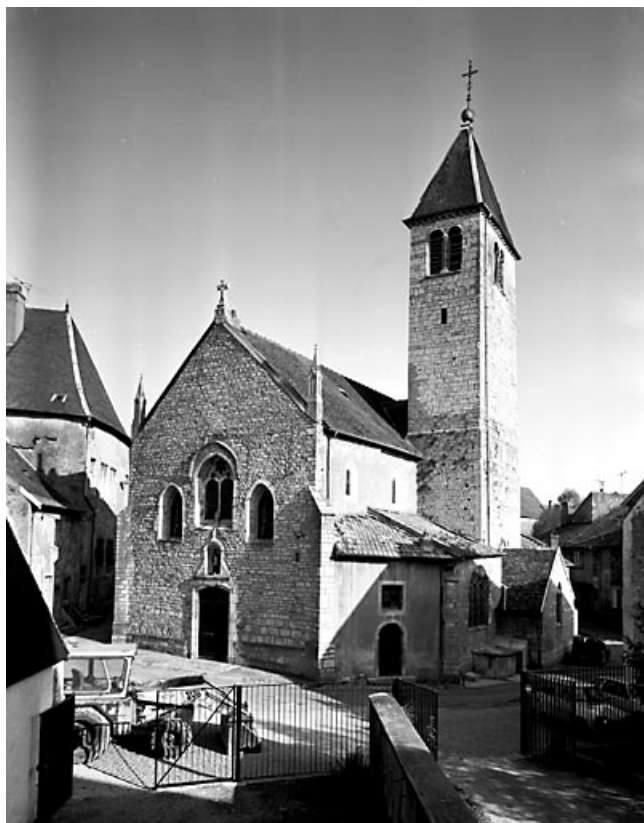
Vue des façades ouest et sud.
