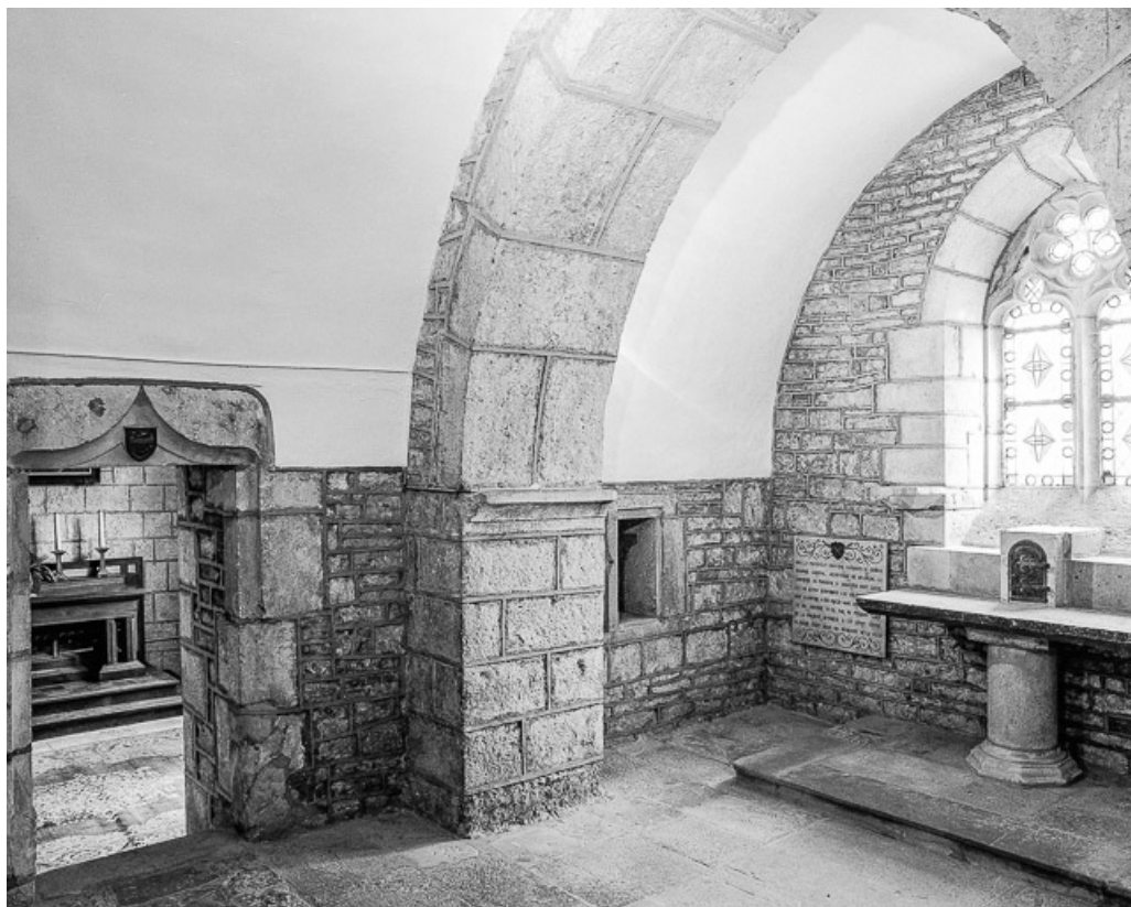
Ancienne chapelle Saint-Sébastien, bas côté droit, deuxième travée. 70, Marnay rue de l' Eglise
