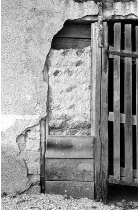
Détail : matériaux de construction.
