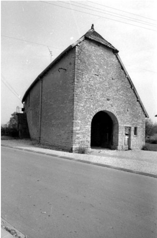
Façades antérieure et latérale droite.
