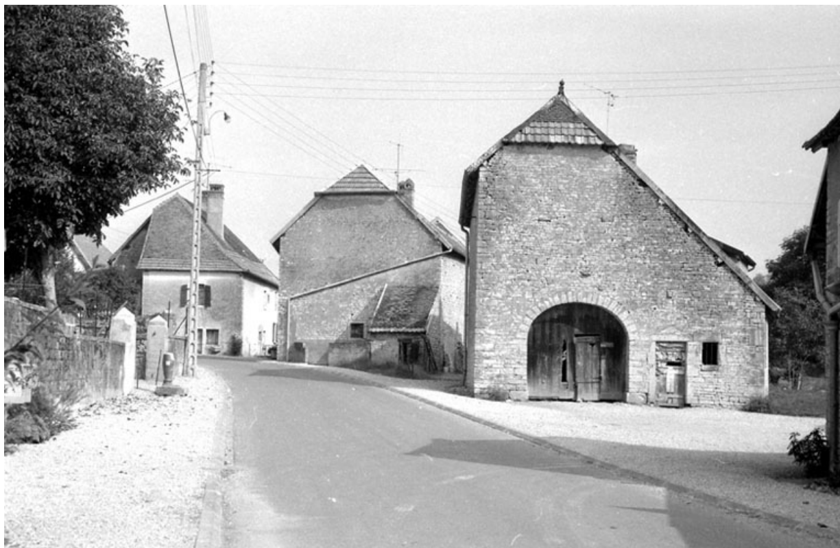
Façade latérale droite.
