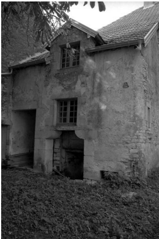
Partie gauche de la ferme. 70, Hugier rue de Pampouille
