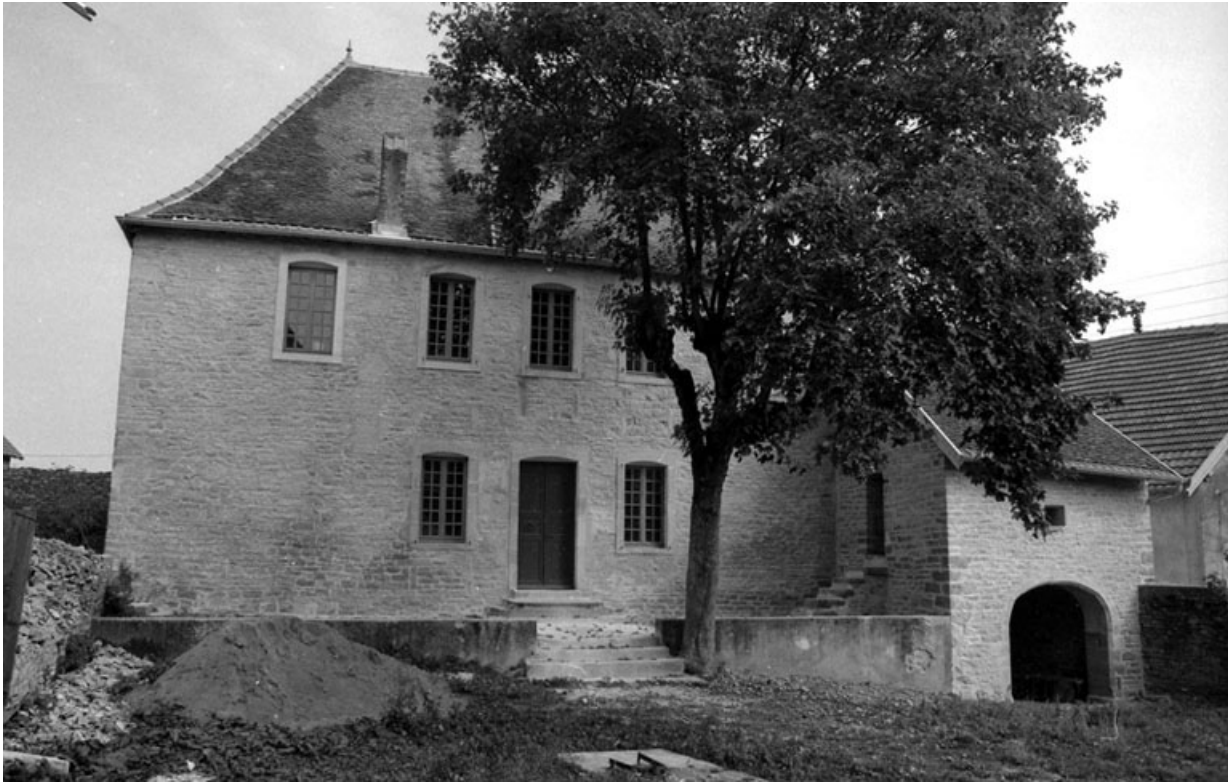
Vue d'ensemble de la maison d'habitation.
