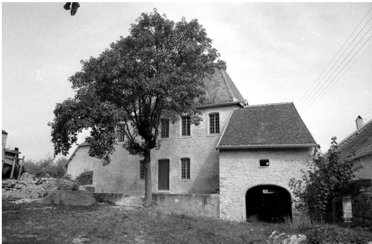
Vue d'ensemble, éloignée, de la maison d'habitation.
