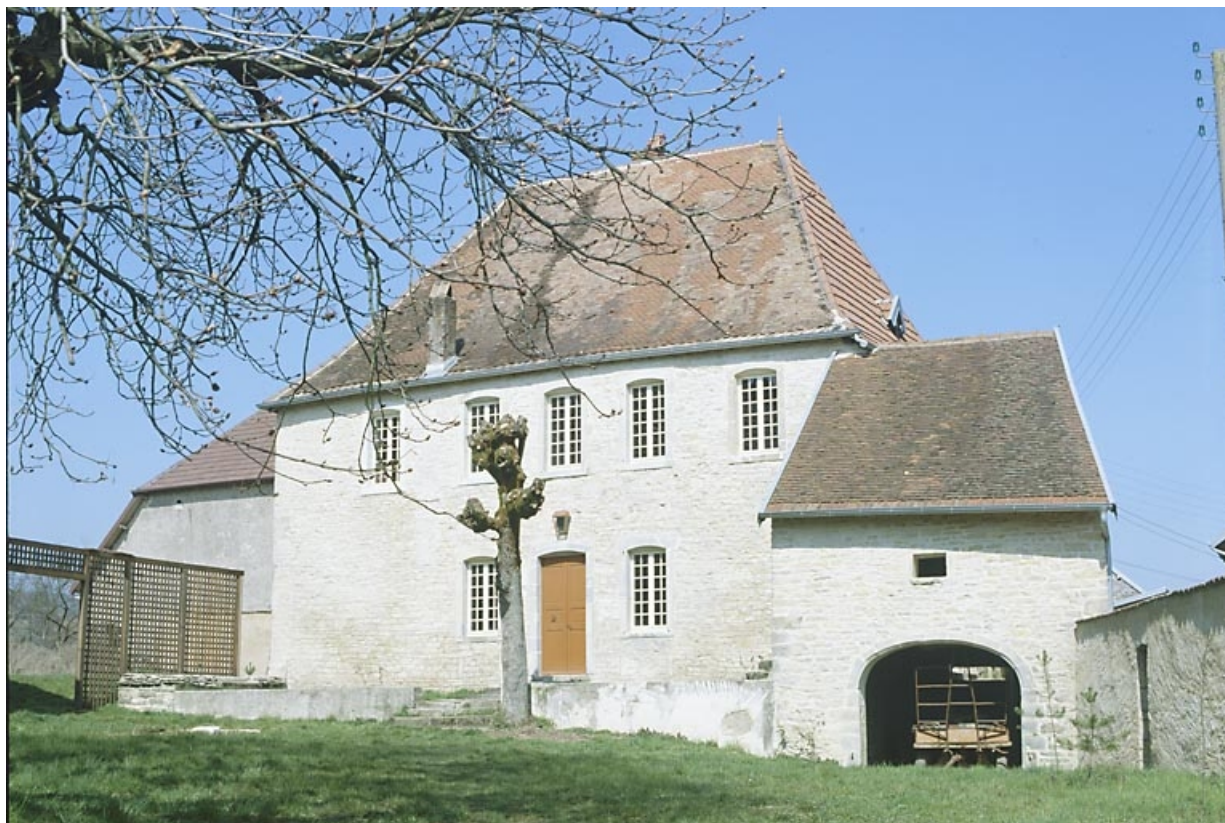
Vue d'ensemble éloignée de la maison d'habitation.
