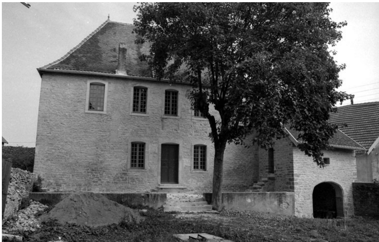
Vue d'ensemble de la maison d'habitation.
