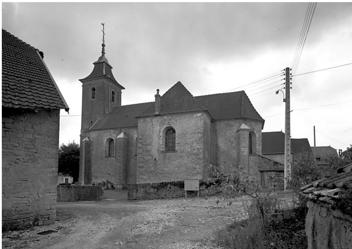
Façade latérale droite.
