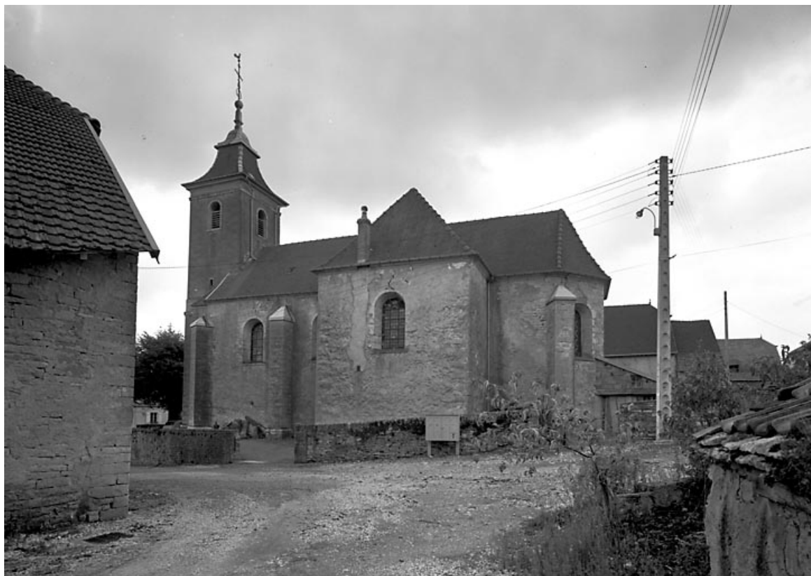
Façade latérale droite.
