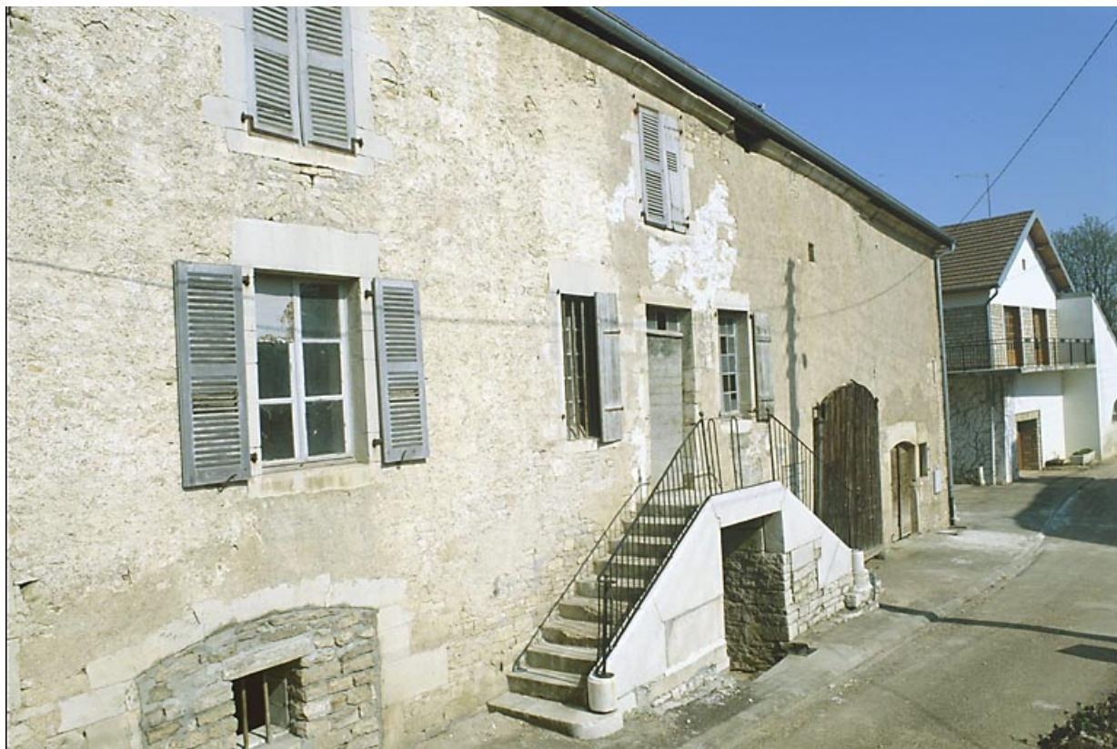
Façade antérieure vue de trois quarts gauche en 1982.
