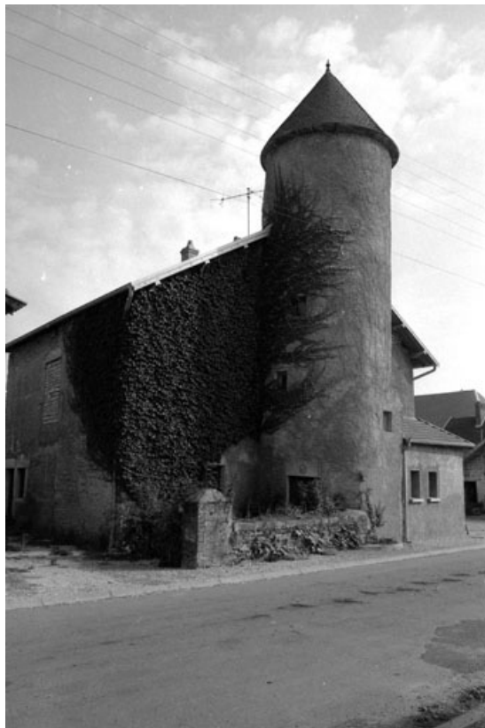
Maison située 7 rue de la Tour : façade sur rue. 70, Hugier
