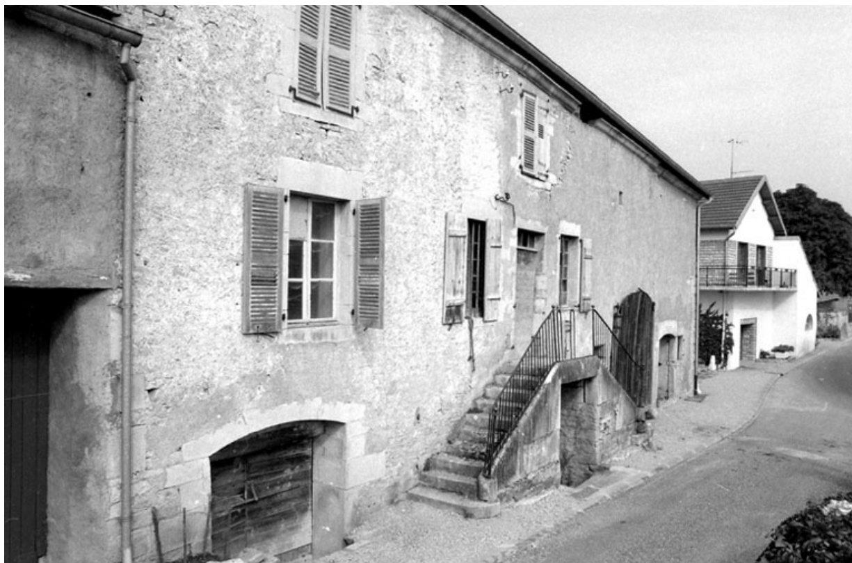
Façade antérieure vue de trois quarts gauche en 1979..
