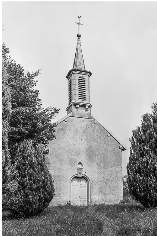
Extérieur : façade antérieure.
