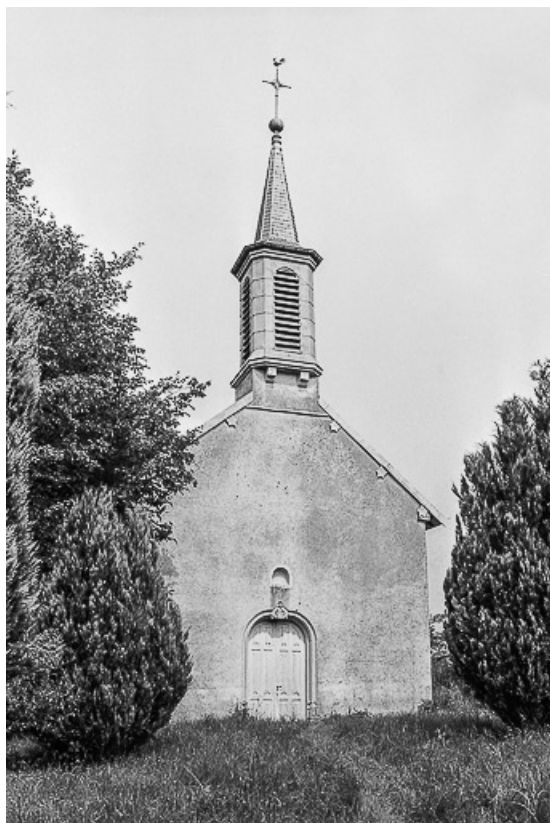
Extérieur : façade antérieure.
