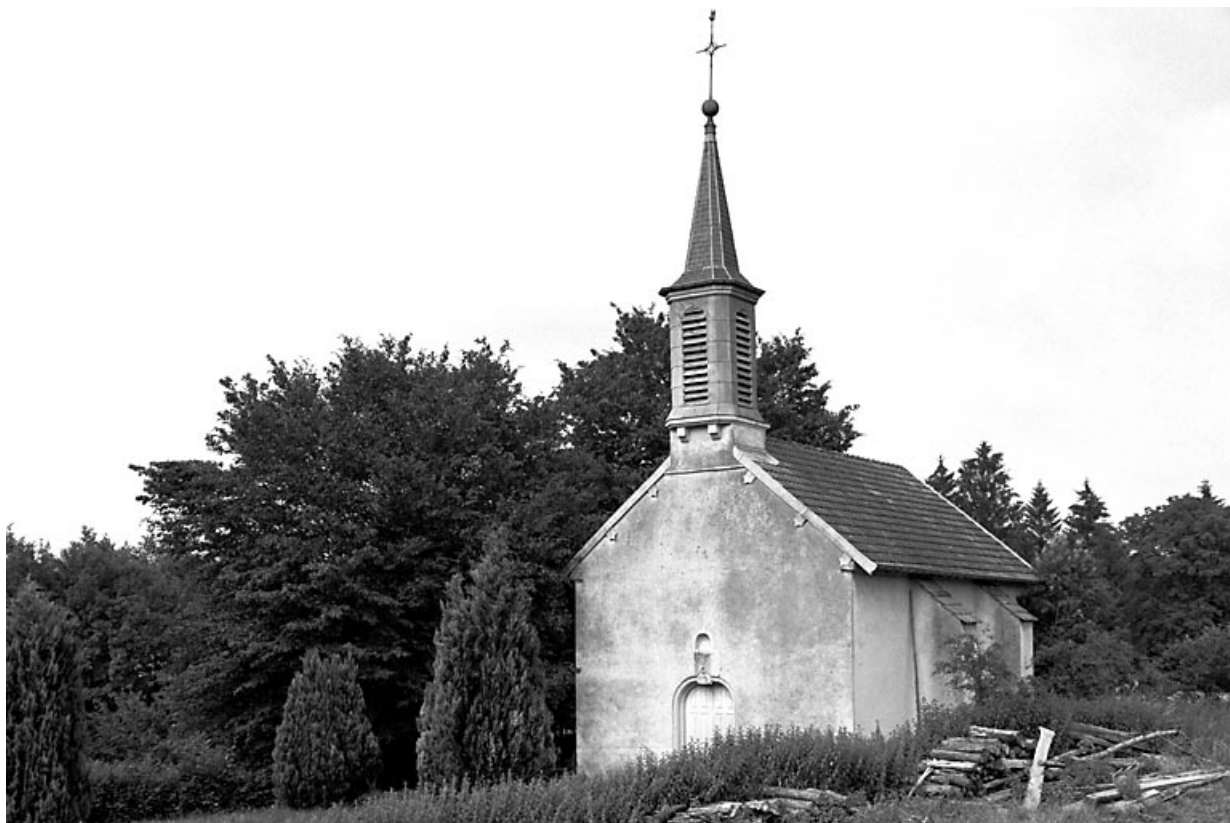
Façades antérieure et latérale droite.
