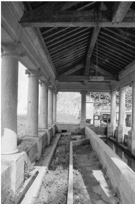
Intérieur : vue d'un bassin.
