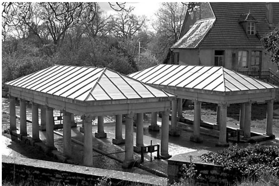
Vue de trois quarts arrière. 70, Étuz rue de la Fontaine
