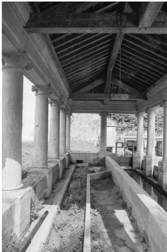
Intérieur : vue d'un bassin.
