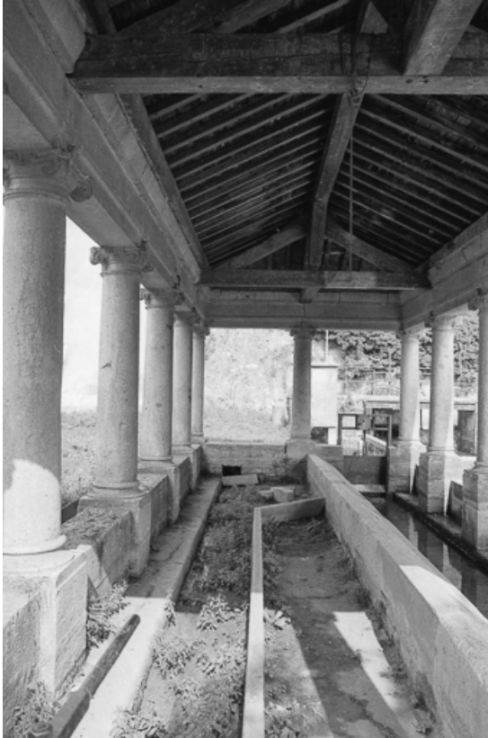
Intérieur : vue d'un bassin.
