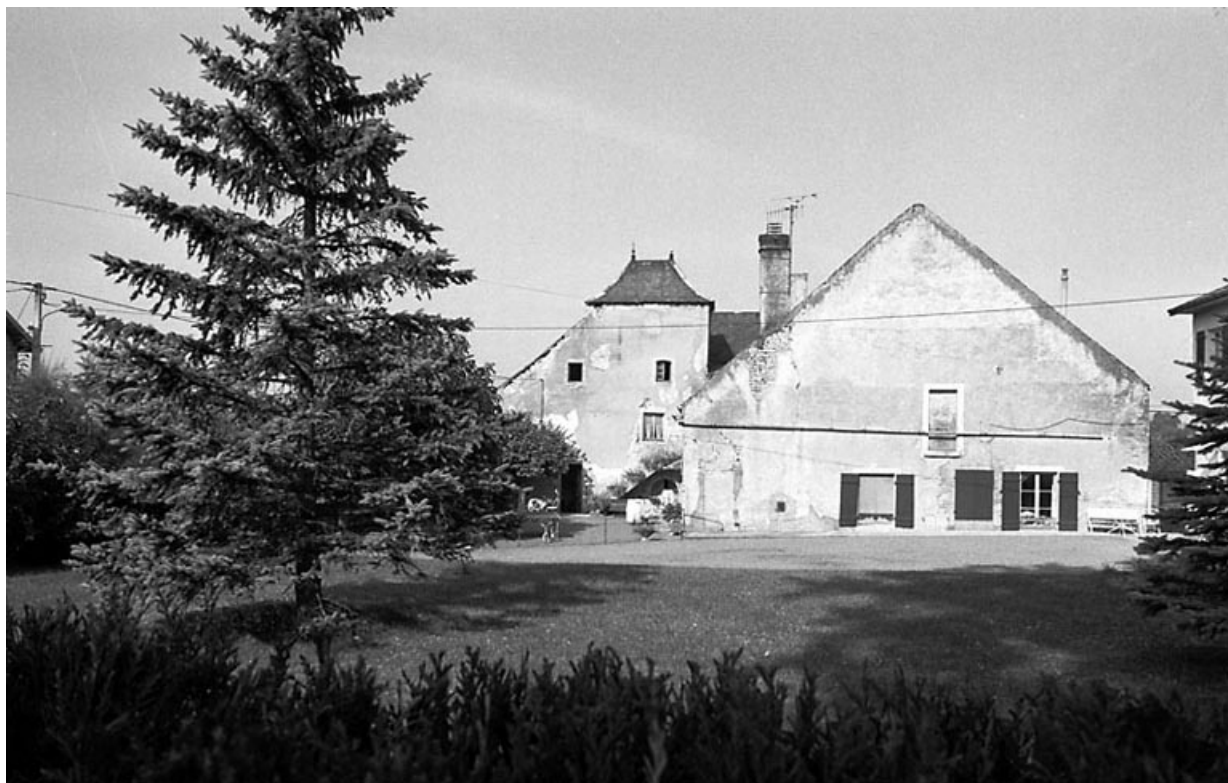
Façade latérale droite.
