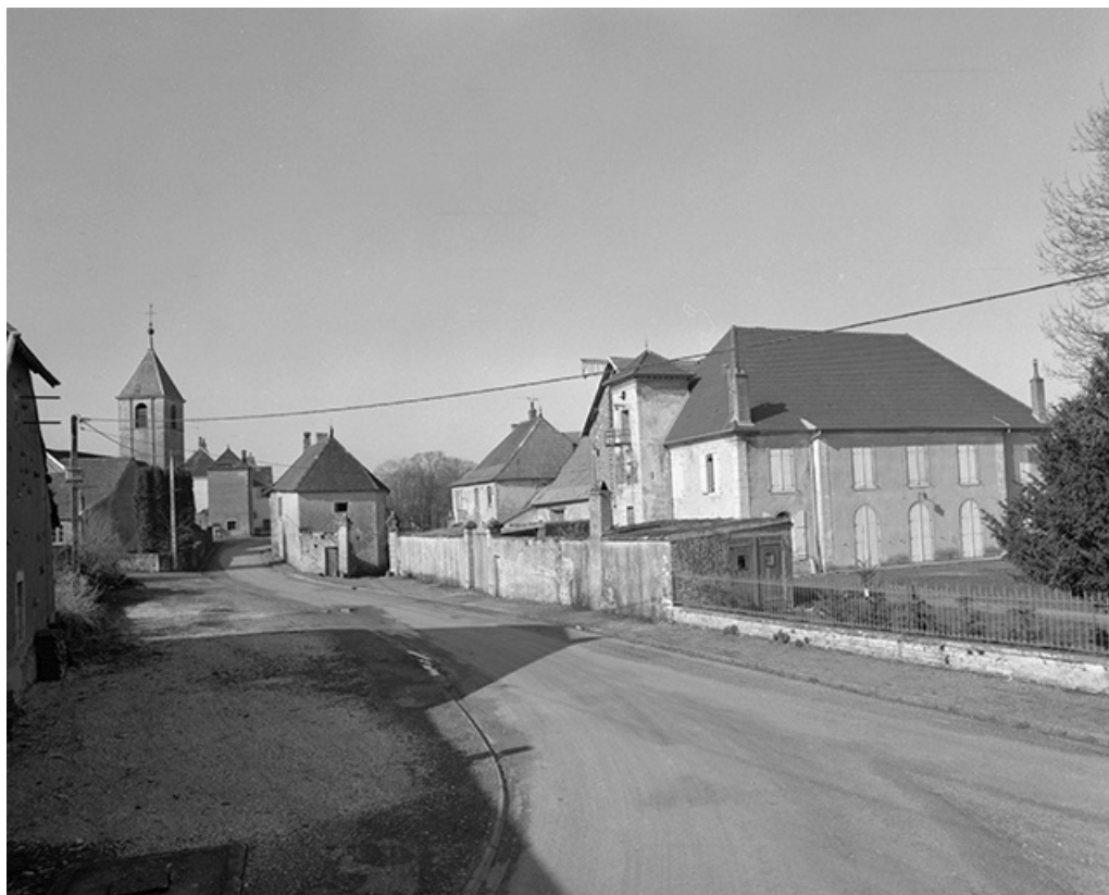
Vue d'ensemble depuis la rue.
