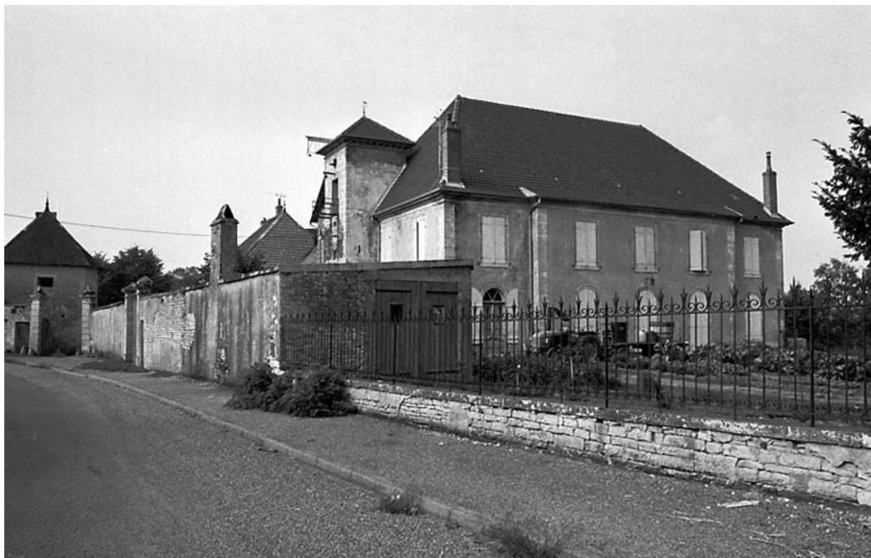
Vue d'ensemble depuis la rue.
