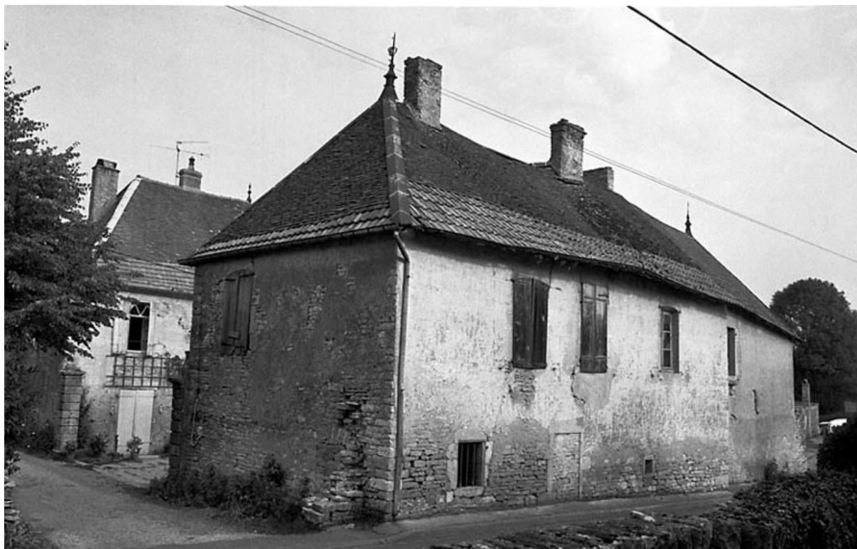
Parties d'habitation vues de trois quarts.
