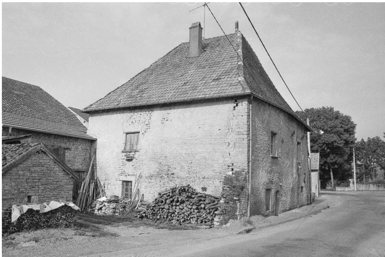
Maison cadastrée 1941 B2 219 : façades sur rue et latérale gauche. 70, Cult
