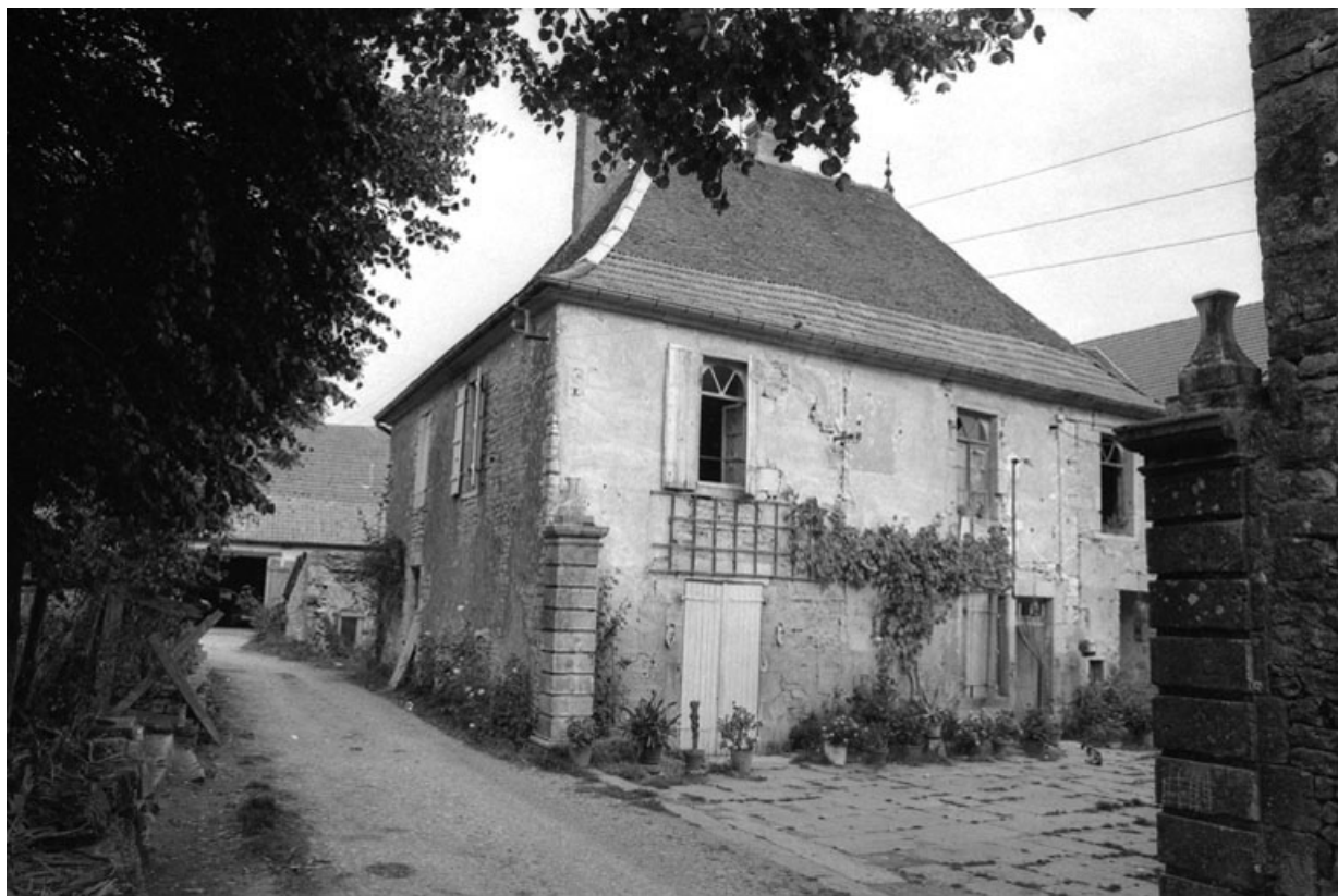
Façade sur cour de l'habitation gauche. 70, Cult
