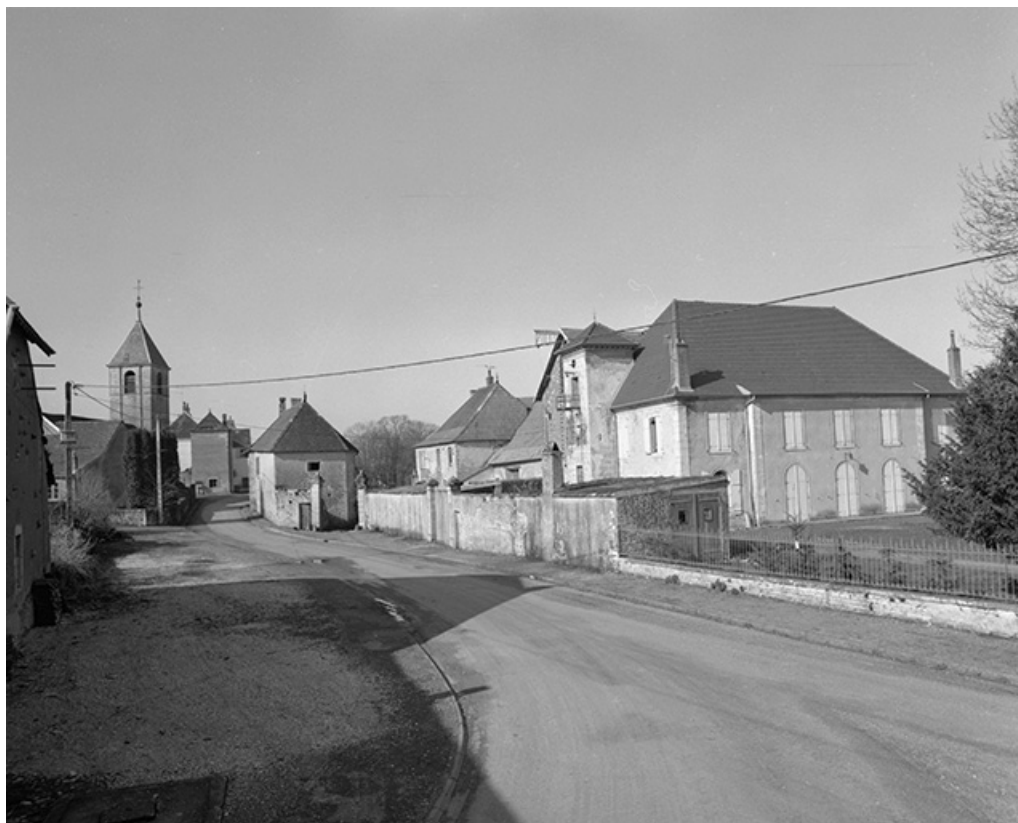
Vue d'ensemble depuis la rue.
