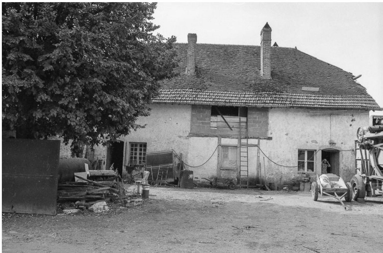
L'habitation : façade sur la cour droite. 70, Cugney rue du Matpierrey
