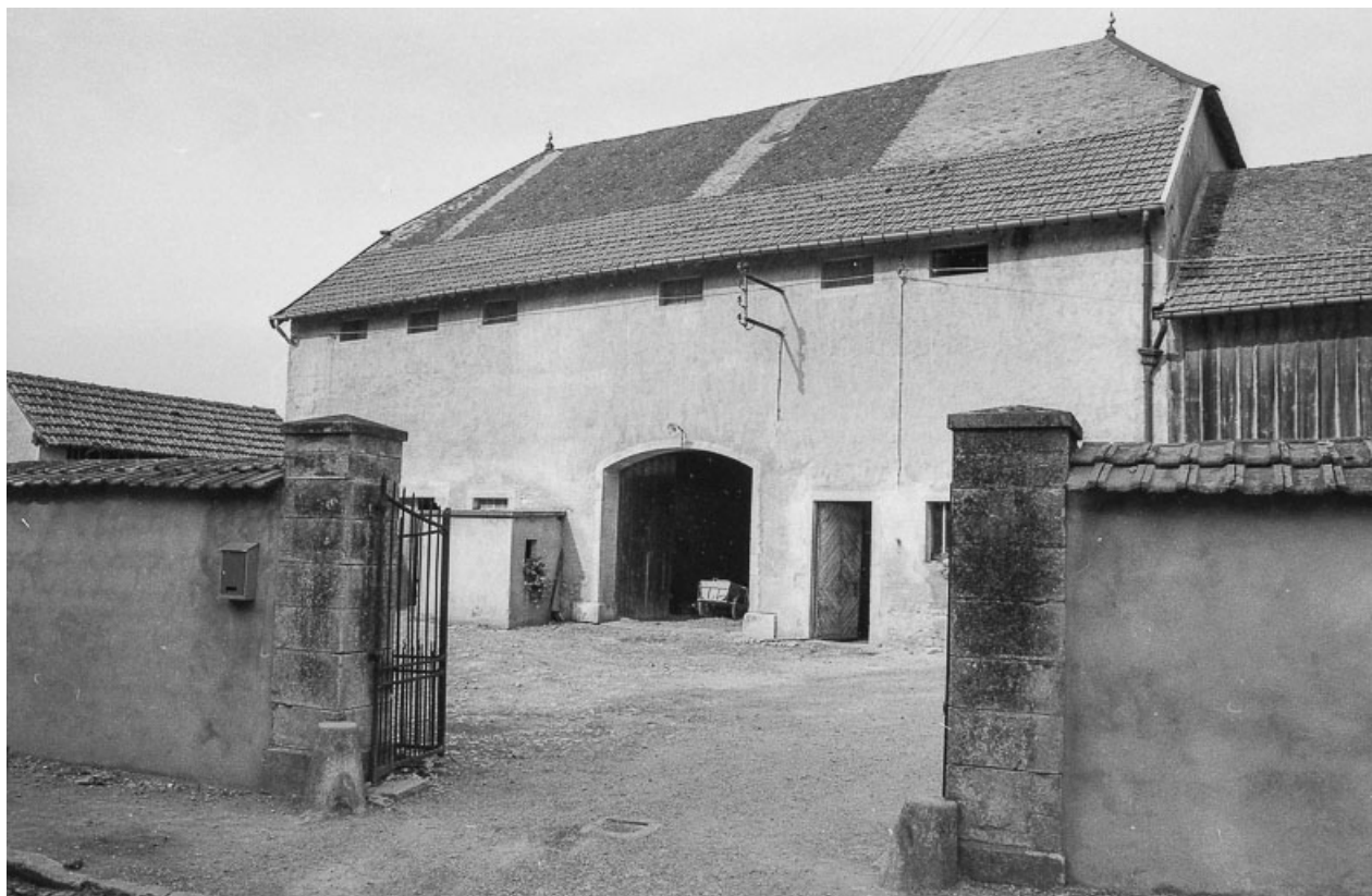
Bâtiment agricole dans la cour de gauche.
