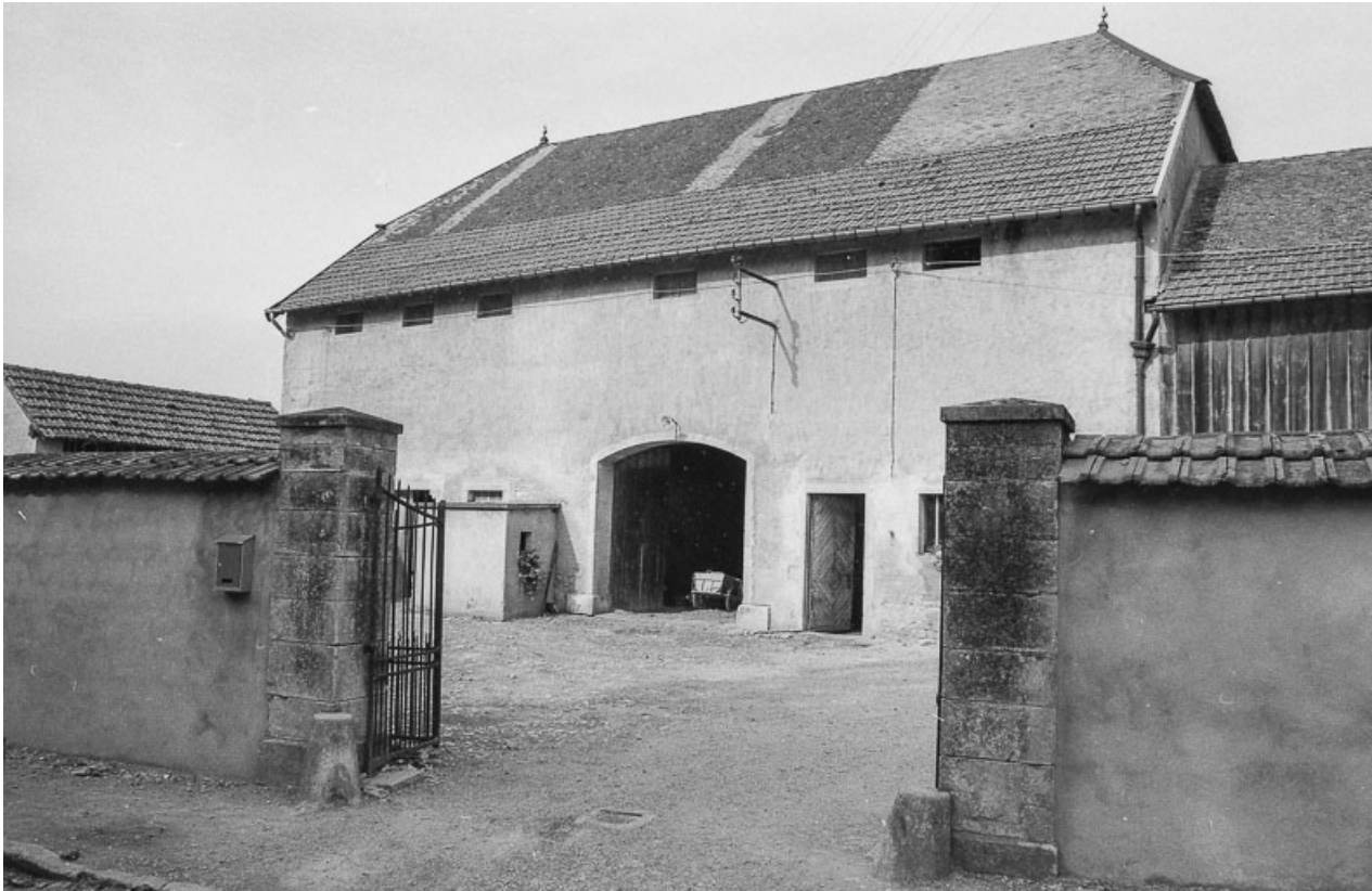
Bâtiment agricole dans la cour de gauche.
